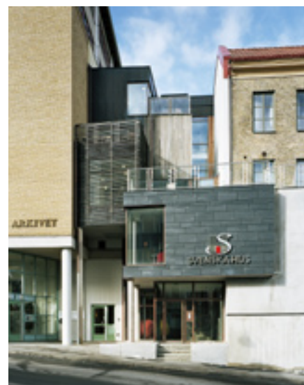
Kontorshus, Otterhällegatan 3, kontrasterande arkitektur som förmedlande länk mellan två byggnader. Arkitekt: QPG Göteborg.
