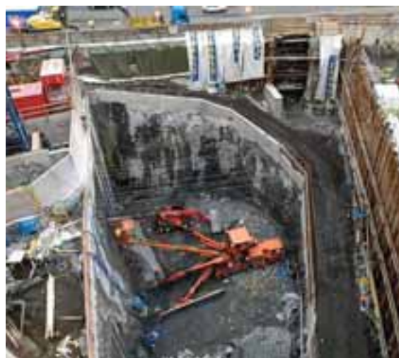
FIGUR 6.5. Exempel på borrhning vid tunnelpåslag. (Foto: Knut Hermansson)
