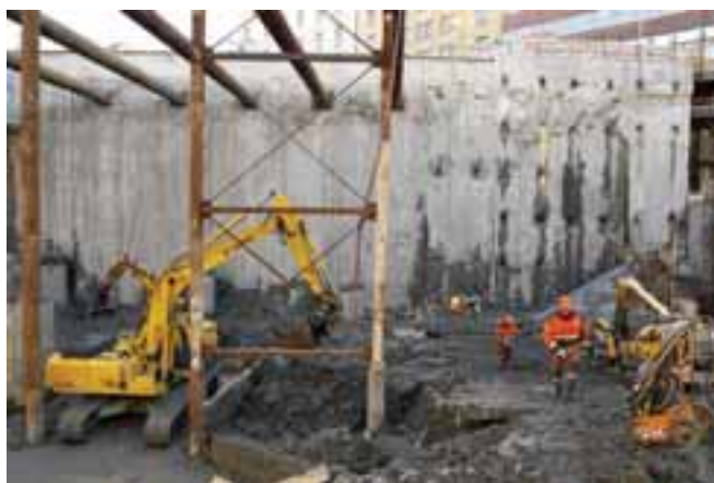
FIGUR 6.7. Exempel på utförande av stödkonstruktion med slitsmur. (Foto: Knut Hermansson)
