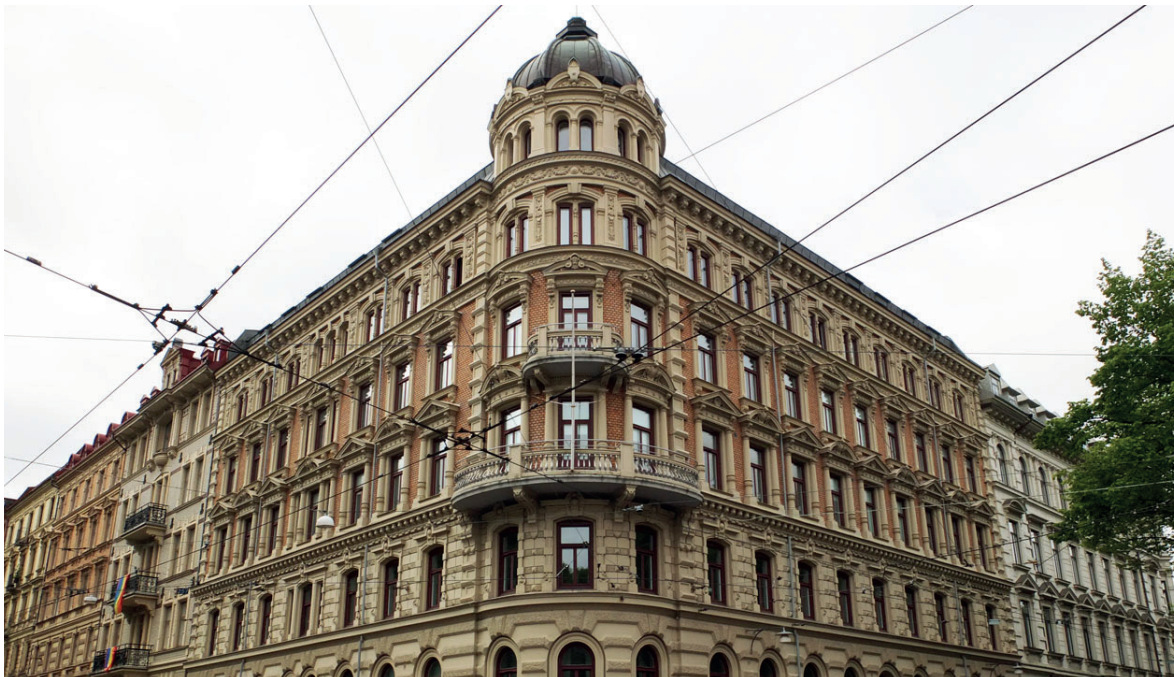
FIGUR 6.12: Bebyggelsen i Vasastaden har ofta rik fasadornamentik som är känsliga för sättningar.
