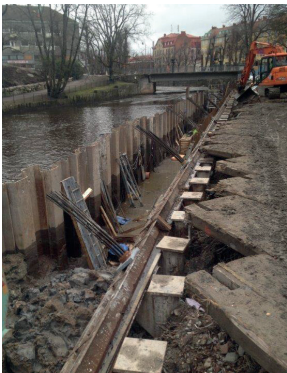
FIGUR 7.1: Schaktning bakom spont (t.v) och miljöskopa (t.h.) är två metoder för att minska spridning av förorenade sediment i vatten.
