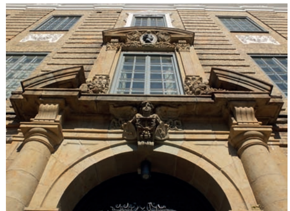
FIGUR 6.5: Skador i form av sprickor i en enkel tegelfasad kan lagas utan att det kulturhistoriska värdet påverkas. En spricka i den rikt ornamenterade tegelfasaden på Sahlgrenska huset kan däremot medföra stora konsekvenser för byggnadens kulturhistoriska värde då fasadornament kan spricka och falla ner.
