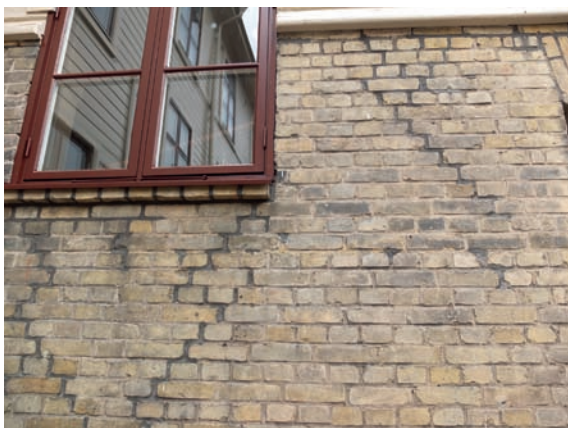
FIGUR 6.5: Skador i form av sprickor i en enkel tegelfasad kan lagas utan att det kulturhistoriska värdet påverkas. En spricka i den rikt ornamenterade tegelfasaden på Sahlgrenska huset kan däremot medföra stora konsekvenser för byggnadens kulturhistoriska värde då fasadornament kan spricka och falla ner.
