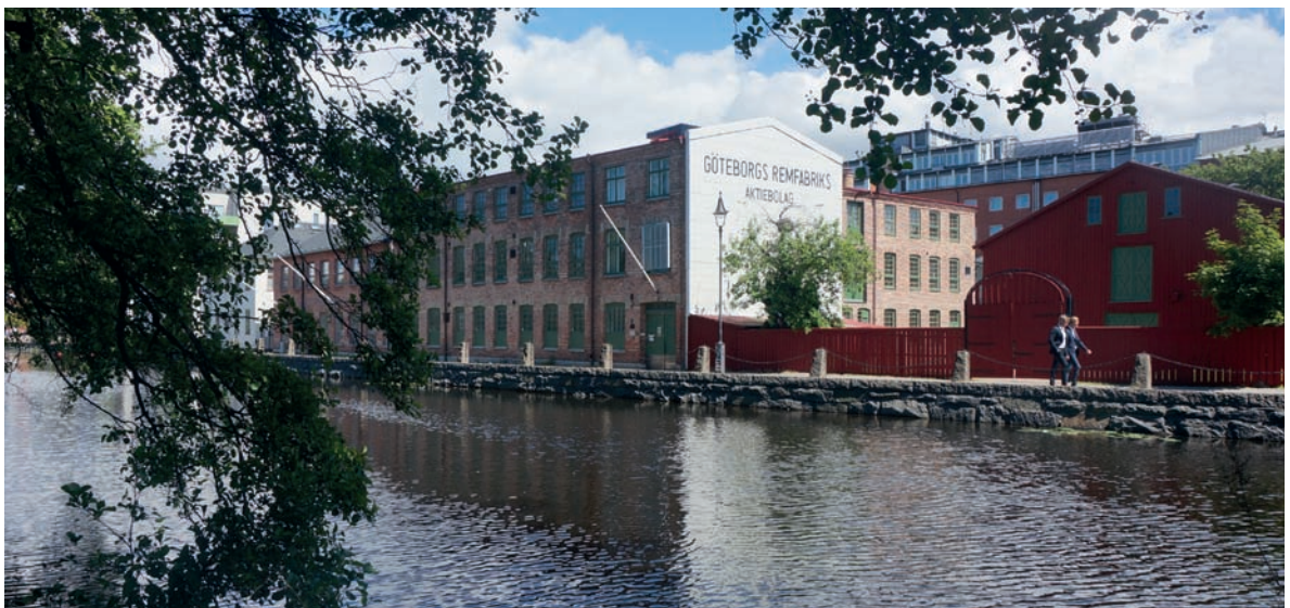
FIGUR 6.14: Remfabriken, ett av delområdets två byggnadsminnen.
