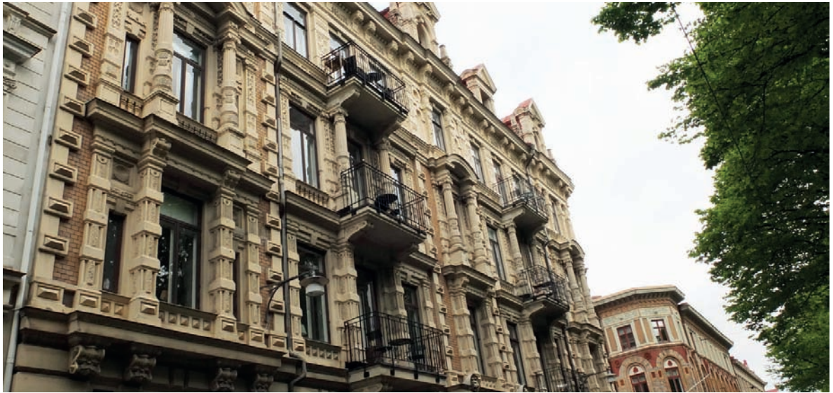
FIGUR 6.4: Fasader uppförda med rik fasadornamentik i puts eller sten är känsliga för sättningar. Under senare delen av 1800-talet var rik fasadornamentik i puts mycket populär och återfinns exempelvis i Vasastadens arkitektur.
