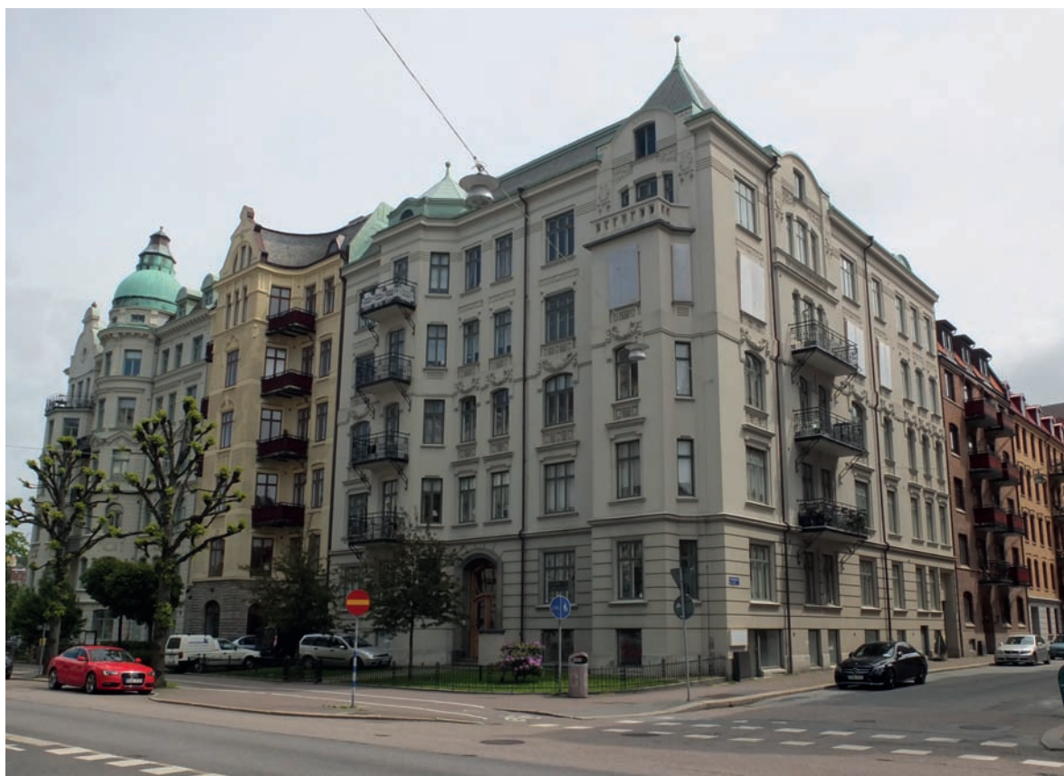
FIGUR 6.17: Nära schaktet vid Korsvägen finns kulturhistoriskt värdefull bostadsbebyggelse som lokalt har sättningskador sedan tidigare. Detta kan leda till kumulativa effekter, dock utan större konsekvenser.
