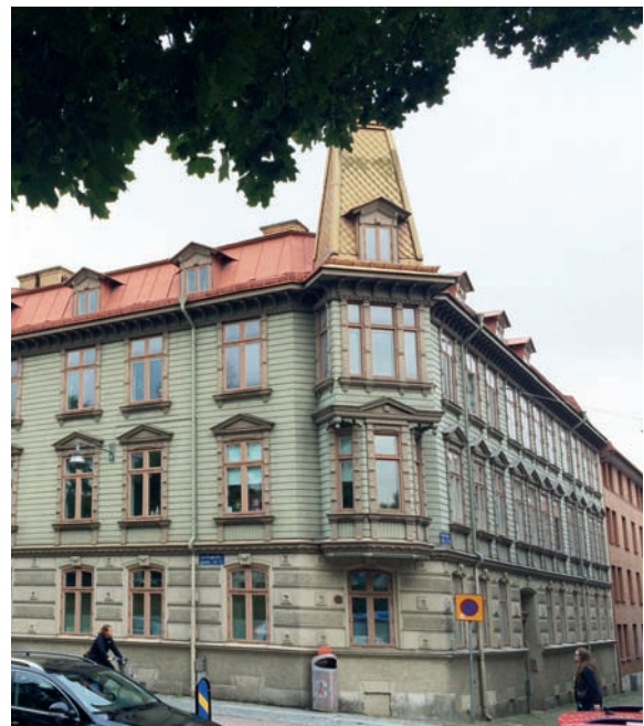
FIGUR 6.16: Byggnader av trä är oftast mindre känsliga för sättningar. Utanpåliggande burspråk, ofta försedda med torn har dock en förhöjd risk att skadas. Hörntorn som är konsolade ut från fasaden är på grund av sin konstruktion känsliga byggnadselement.
