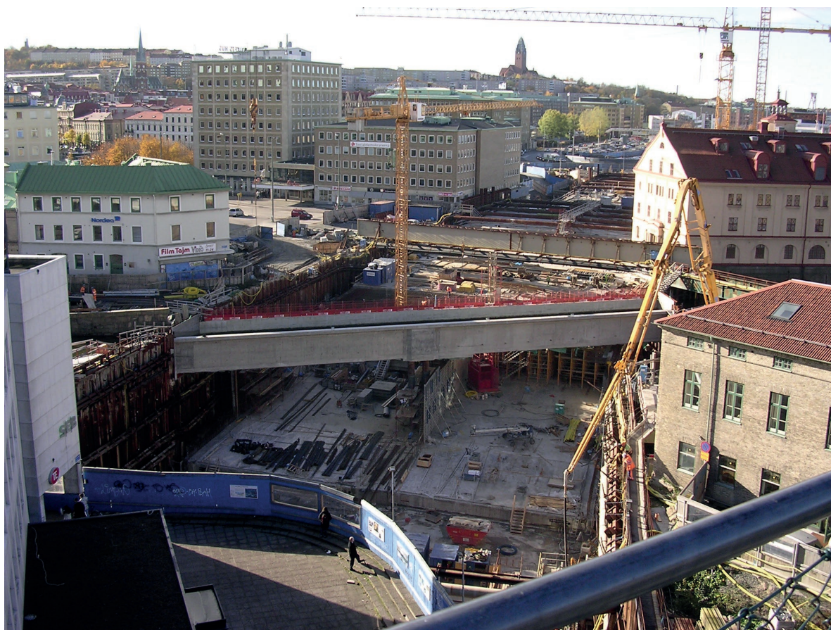
FIGUR 5.4 Jordschakt vid bygget av Götatunneln.
