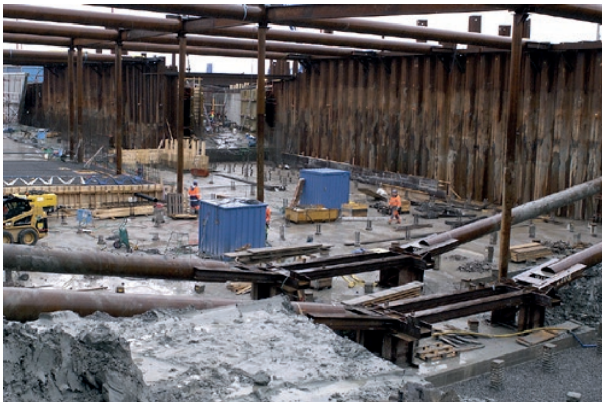
FIGUR 5.5 Stålspont (med stämp) vid arbeten i Götatunneln.
