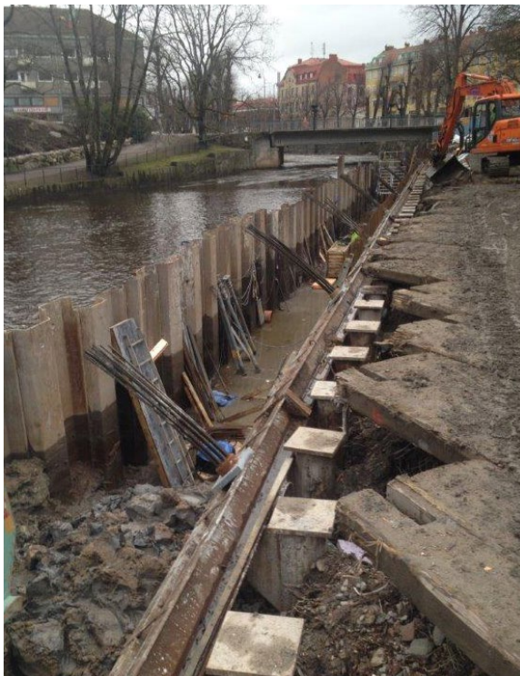
FIGUR 7.1: Schaktning bakom spont (t.v) och miljösopa (t.h.) är två metoder för att minska spridning av förorenade sediment i vatten.
