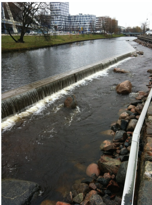
Figur 8: Fiskväg vid Gårda Dämme. Foto: Christian Åberg, EnviroPlanning
