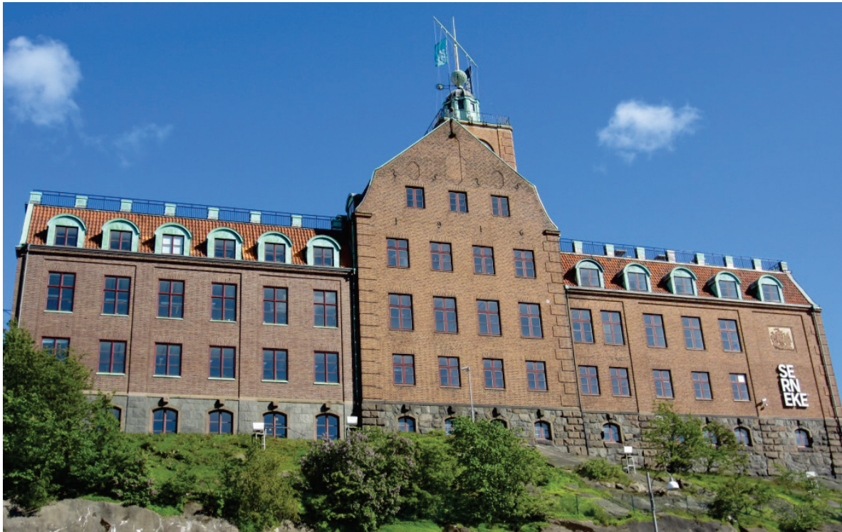
Figur 20: Före detta Navigationsskolans lokaler uppförda på Kvarnberget, utgör också en viktig del i det monumentala formspråk som präglar bebyggelsen vid hamnstråket. Foto; Jenny Torle, Acanthus.
