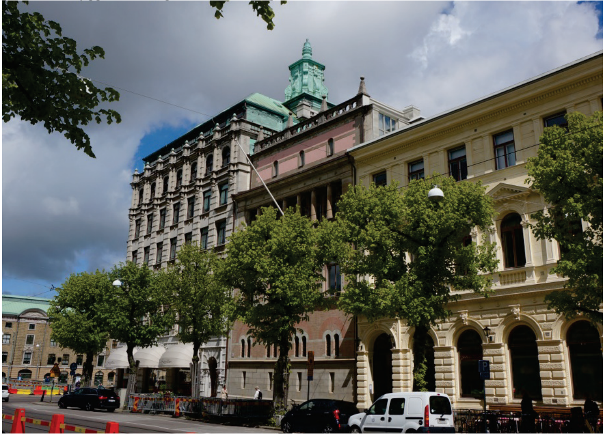
Figur 15: Försäkrings AB Skandias byggnad uppförd 1909 på hörnet mot Södra Hamngatan flankeras av Skandinaviska bankens byggnader i florentinsk respektive romersk nyrenässans från 1895 respektive 1882. Foto; Maria Olovsson, Acanthus.
