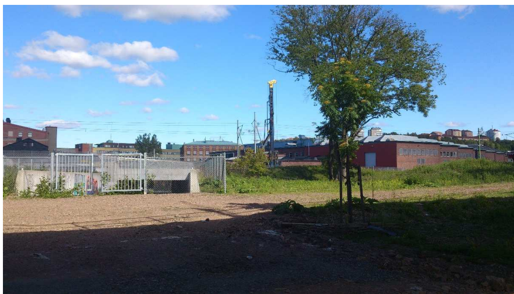
Figur 14 Pålning i position P2, arbetet sker parallellt med arbetet i position P1.
