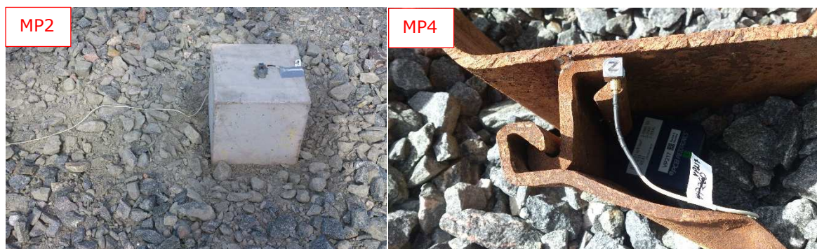
Figur 3 Markvibrationsmätningar vid Sävåån, mätposition MP2 på betongkloss samt MP4 på stålspons.
