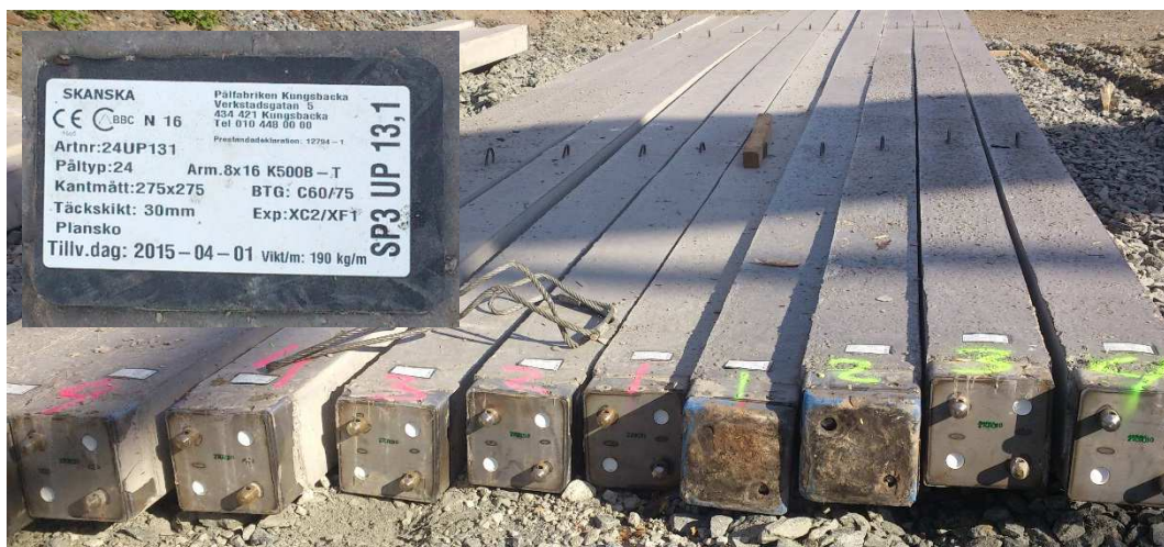
Figur 13 De betongpålar som används vid pålning med pålmaskin i position P1.
