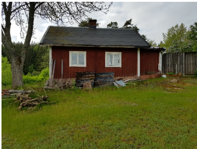
Figur 6.5.2. Bullerberört bostadsbyggnad på fastigheten Glia 1:6 (1000006018).
