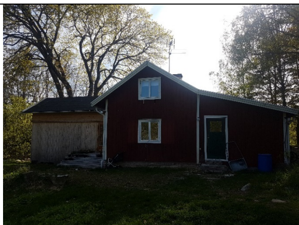
Figur 6.5.4. Bullerberörd bostadsbyggnad på fastigheten Håknäs 4:16.
