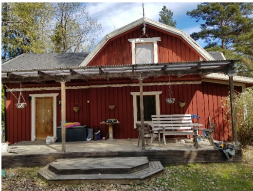
Figur 6.5.6. Bullerberörd byggnad på fastigheten Smedsta 1:24.
