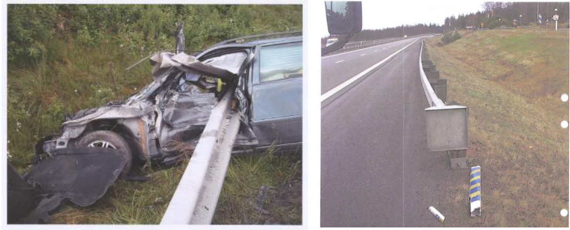
Figur 21 Exempel på sidokollision mot tvär räckesände.
