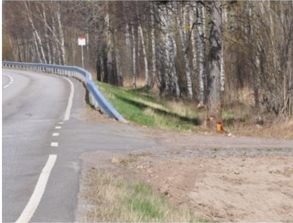
Figur 19 Exempel på avkörning i sidoområde med oeftergivligt föremål.
