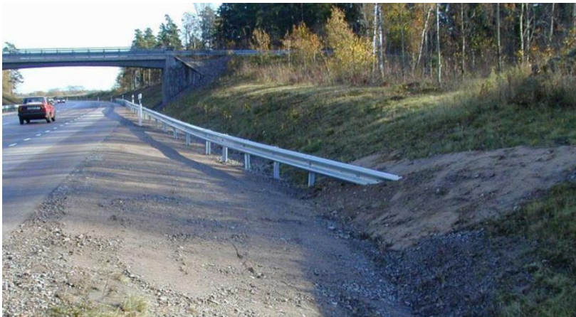
Figur 22 Exempel på en åtgärdad räckesände och borttagning av vägtrumma.
