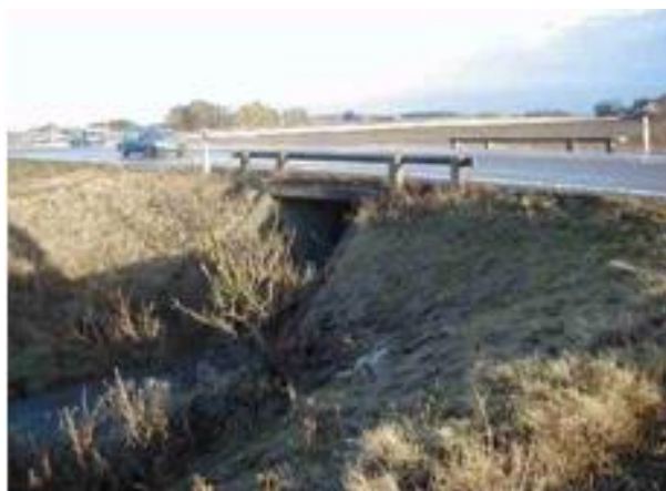
Figur 20 Exempel på ett för kort räcke som behöver förlängas.
