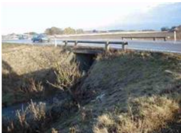
Figur 6-20 Exempel på ett för kort räcke som behöver förlängas.
