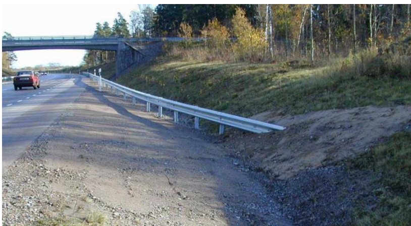
Figur 6-6-22 Exempel på en åtgärdad räckesände och borttagning av vägtrumma.
