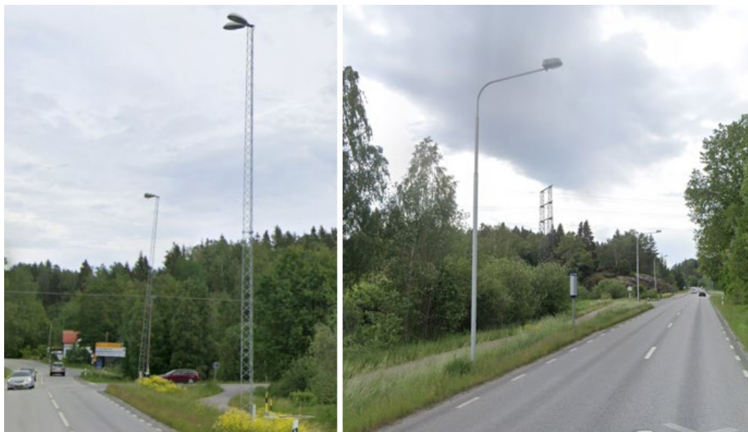
Figur 6. Bilderna ovan är från Google Maps. Bilden till vänster visar fackverksmaster och den till höger visar belysningsstolpar (Moramast). Källa: Google Maps
