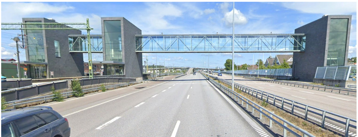
Figur 4.10.4–1. Gångbro som sträcker sig från plattformarna till resecentrum och pendelparkering. Bild hämtad från Google maps 2025-02-06.
