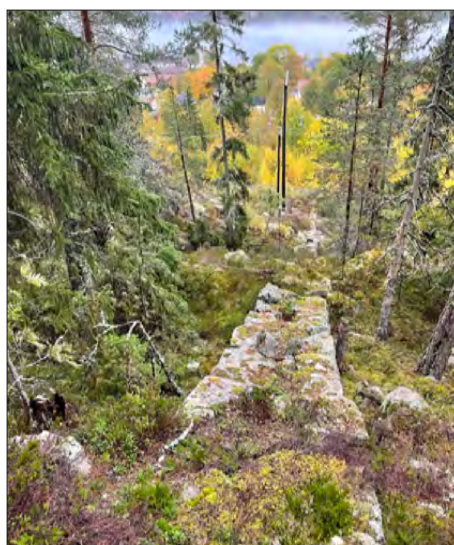
Figur 9.2:6 En kallmurad stenkonstruktion leder upp till platsen där en gång kastellet stod.
