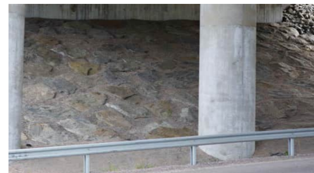
Figur 54. Stenläggning under vägbro.
