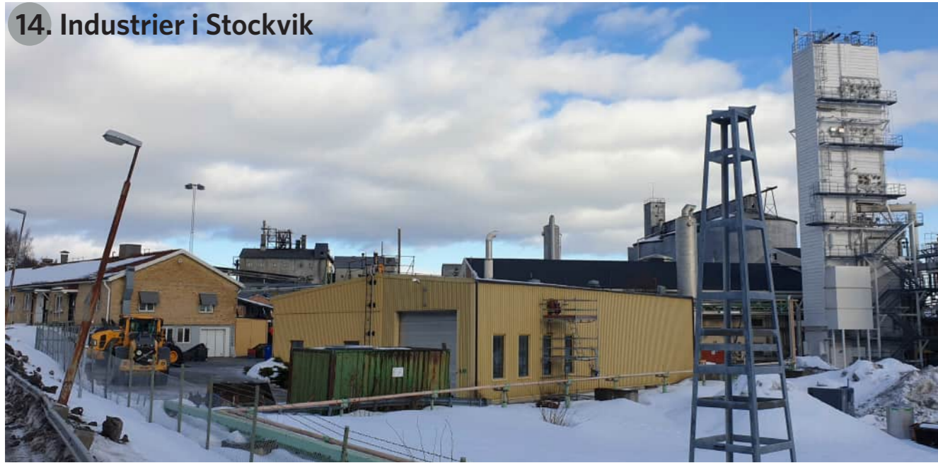
Figur 17. Stockviksverken sett från Södra infarten.
