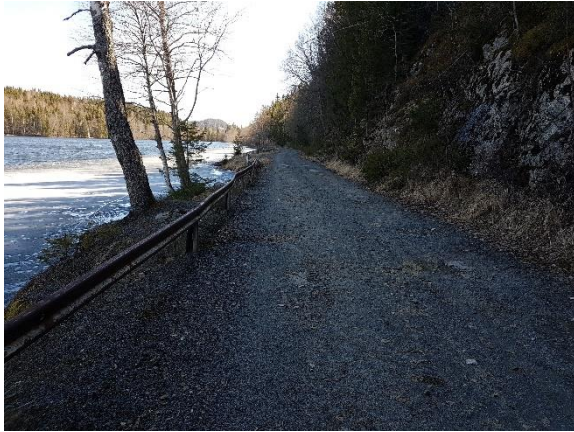
Figur 5.13. Väg 839 längs Storsjön. Räckets på bilden utgörs av ett w-format stålräcke med huggen sten (s.k. stengardister) som räckesstolpar.
