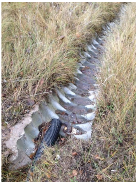
Figur 16. Exempel halvtrumma som kan anläggas för att undvika erosion vid branta slänter.
