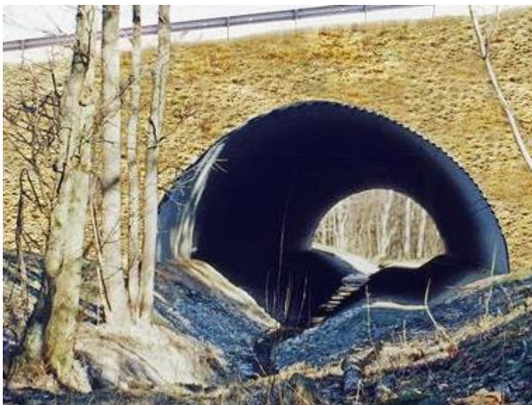
Figur 15. Exempel halvtrumma som kan anläggas som faunapassage (tanken är dock en mindre variant).
