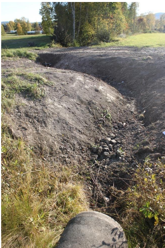
Figur 17: Dike som avvattnar del av väg i sektion 115/267.
