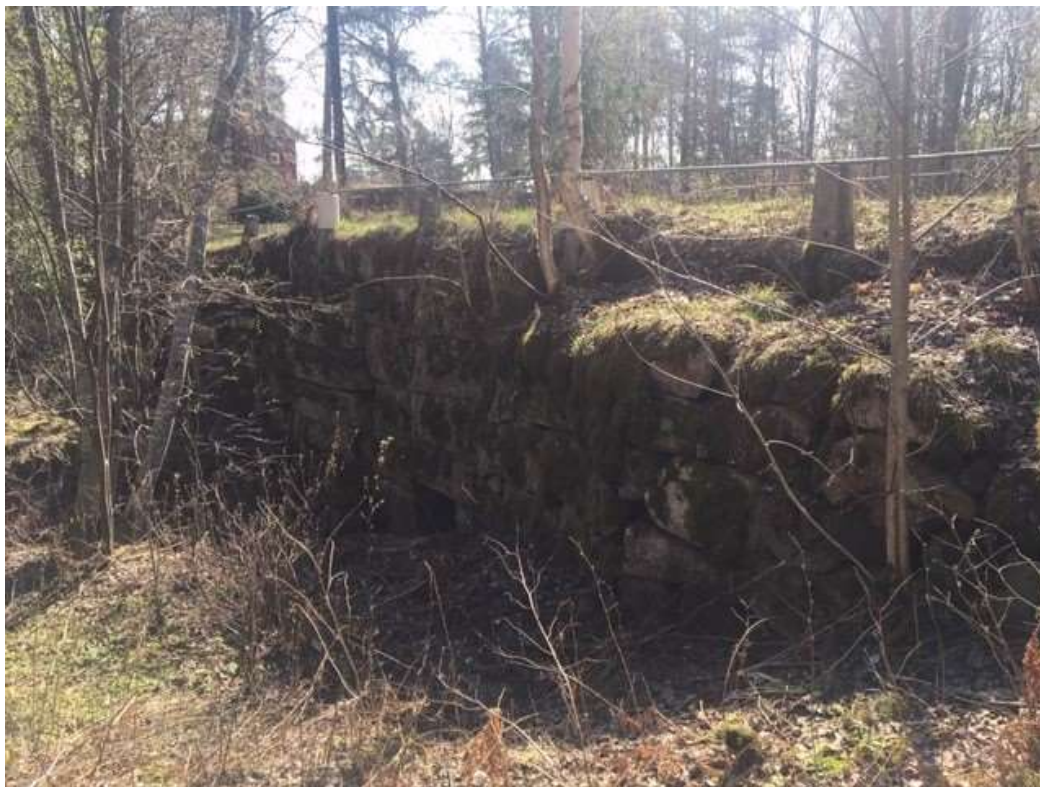
Figur 7. Bron över Sifferbäcken(L2001:5803) kan bli föremål för åtgärder för att öka vattenflödet.
