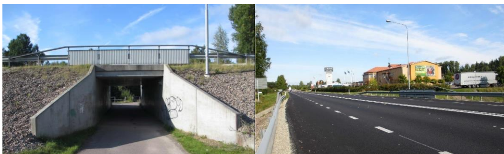
Bild 2. Bro 20-965-1: Elevation mot sydväst respektive vy mot nordväst.
