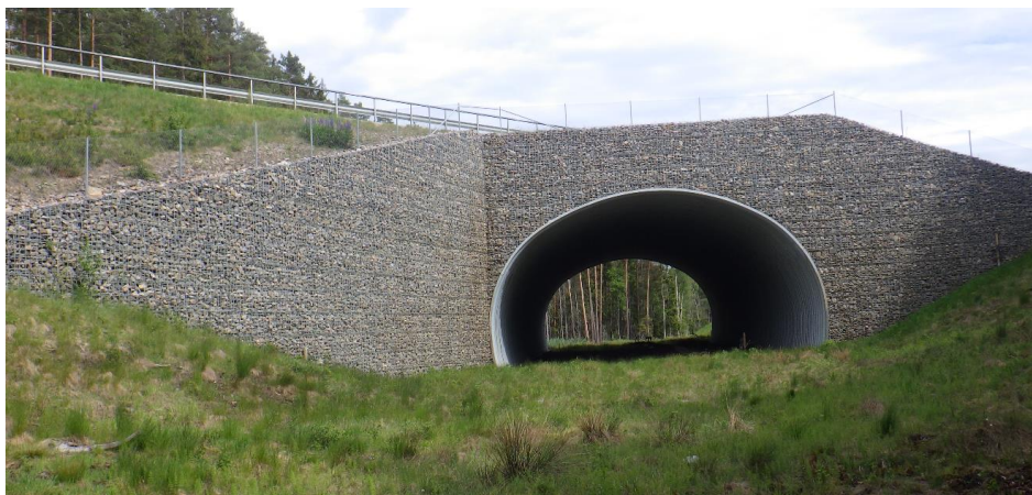
Bild 8. Valvbåge. Bro 15-1785-1. Källa: Trafikverket BaTMan.
