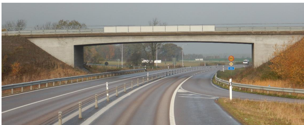
Bild 7. Plattrambro. Bro 12-1327-1. Källa: Trafikverket BaTMan.
