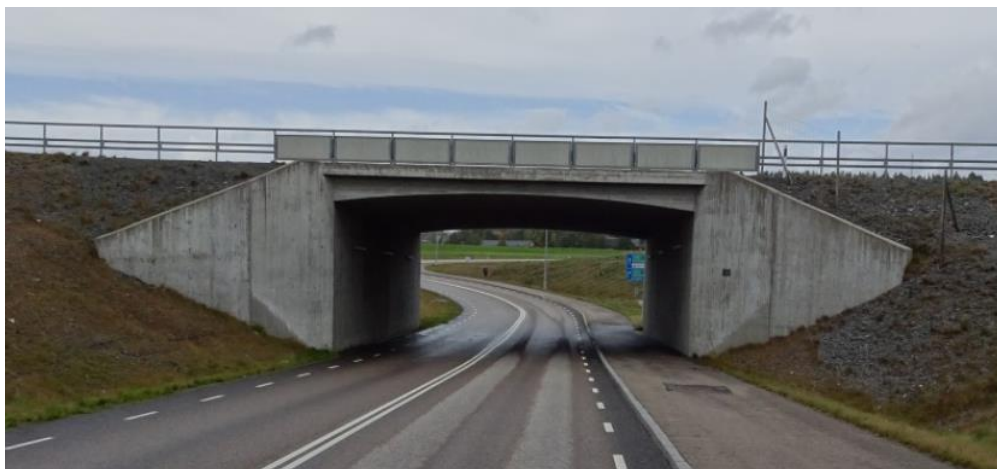
Bild 69. Plattrambro med sneda vingar och stödmurar. För raka vingar jämför bild nedanför. Bro 15-1711-1. Källa: Trafikverket BaTMan.
