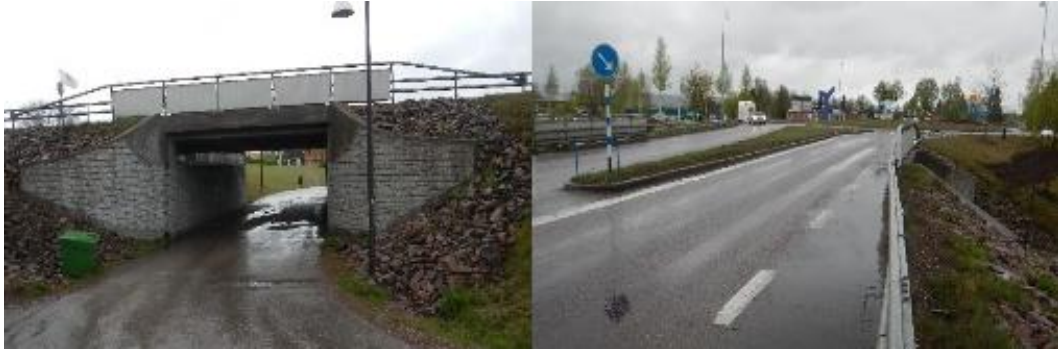
Figur 17. Visar bro 20-1318-1. Bilden till vänster visar bron i vinkel från norr och bilden till höger visar vy från öster.
