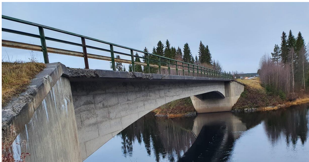
Figur 4. Befintlig bro över Vojmån vid Strömåker. Foto: Norconsult AB.
