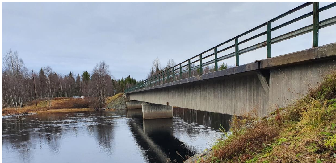
Figur 4. Befintlig bro över Vojmån vid Bäsksese. Foto: Norconsult AB.
