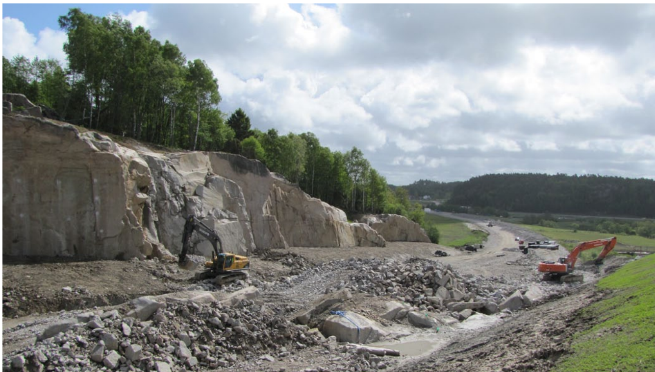
Ett omsorgsfullt arbete med bergskärningar utmed E6 norr om Tanumshede.
