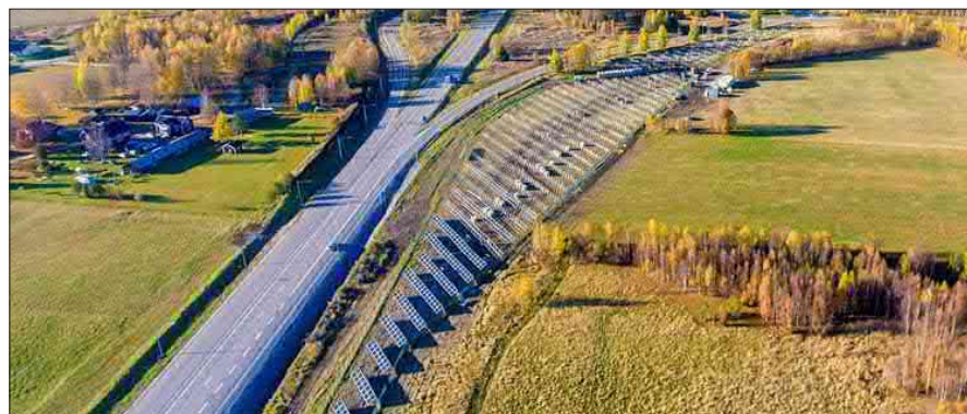
Figur 4.2:10 Luleå Energi solelspark 800-1000 kW installerad effekt, cirka 13 000 kvadratmeter.
