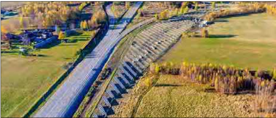
Figur 4.2:10 Luleå Energi solelspark 800-1000 kW installerad effekt, ca 13 000 m².
