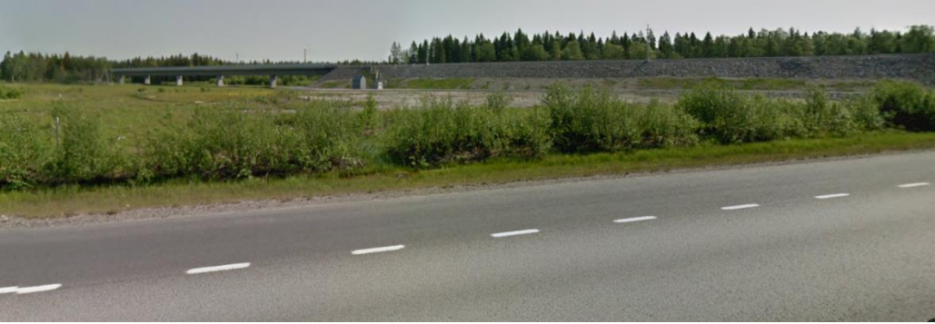
Botniabanan vid E12, bank och landskapsbro (förlängning av bron över Ume älv, söder)
