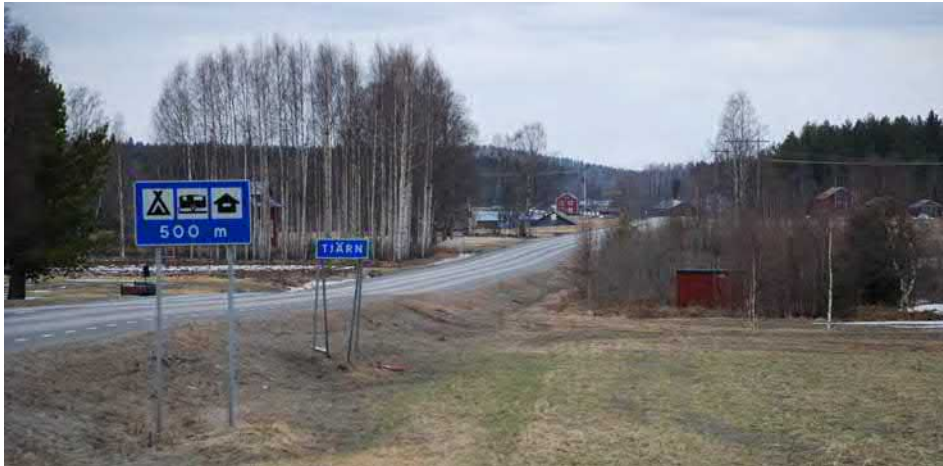
Figur 3.1:2 Väg 824 vid Tjärn. Foto: ÅF
