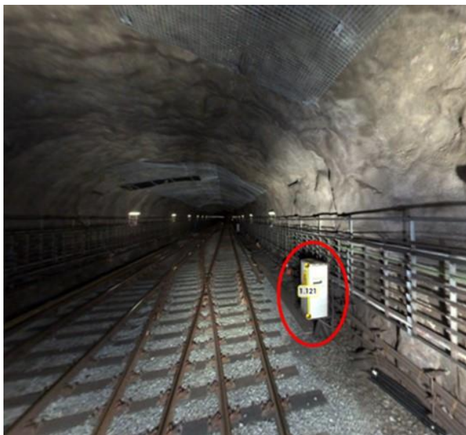
Figur 7.2.3.6. Exempel på bild tagen i SL:s underjordsanläggningar.
