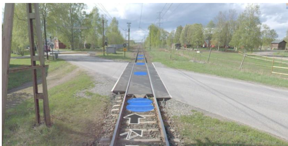
Figur 7.2.3.4. Bild över vägövergång där slipersbyte ska utföras.
