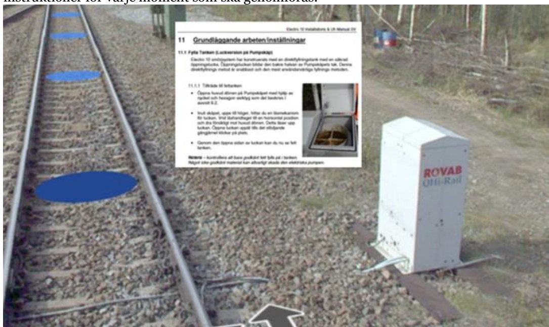
Figur 7.2.4.5. Exempel på förstärkt verklighet, teknikern kan få upp rätt underhållsinstruktion när teknikern är i närheten av smörjapparat.
