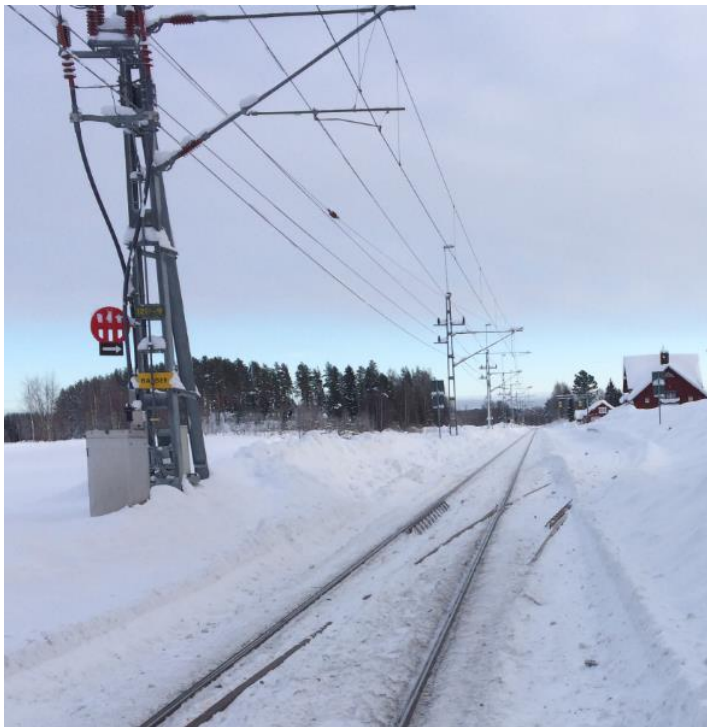
Figur 7.2.3.7. Bild av järnvägsanläggningen taget vid fältbesök.
