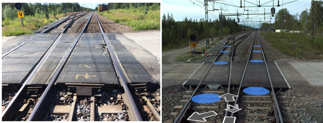
Figur 7.2.5.1 byte av Strail i plankorsning
