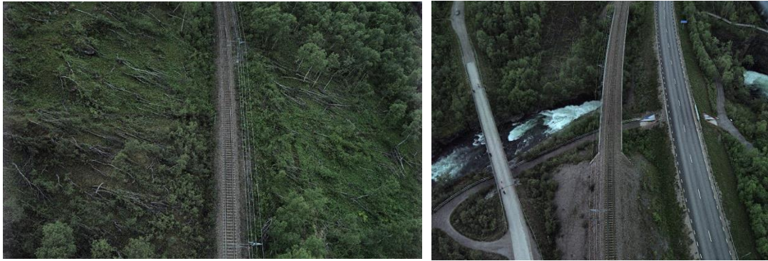
Figur 7.1.2.5. Exempel på lavinområde, i bilden ses tydligt hur träden har lagt sig. Högra bilden översikt över angränsande anläggningar.
