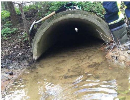
Bild 2. Betongtrumma, befintlig väg 50, april 2016. Diameter 1000 mm.
