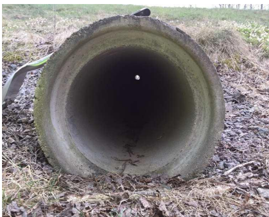
Bild 4. Torr betongtrumma, april 2016. Diameter 500 mm.
