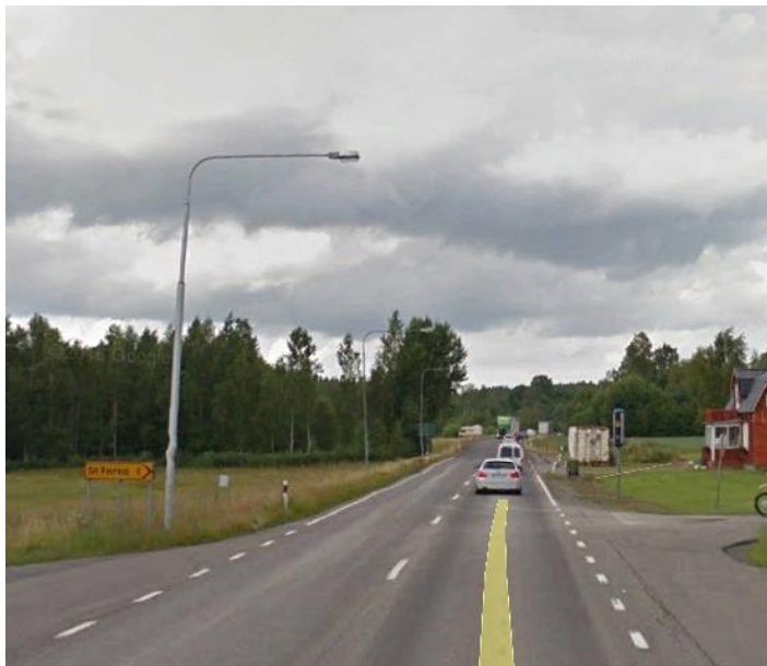
Belysning vid Stora Forsa. Armatur Thorn 7440C 150W Na.
