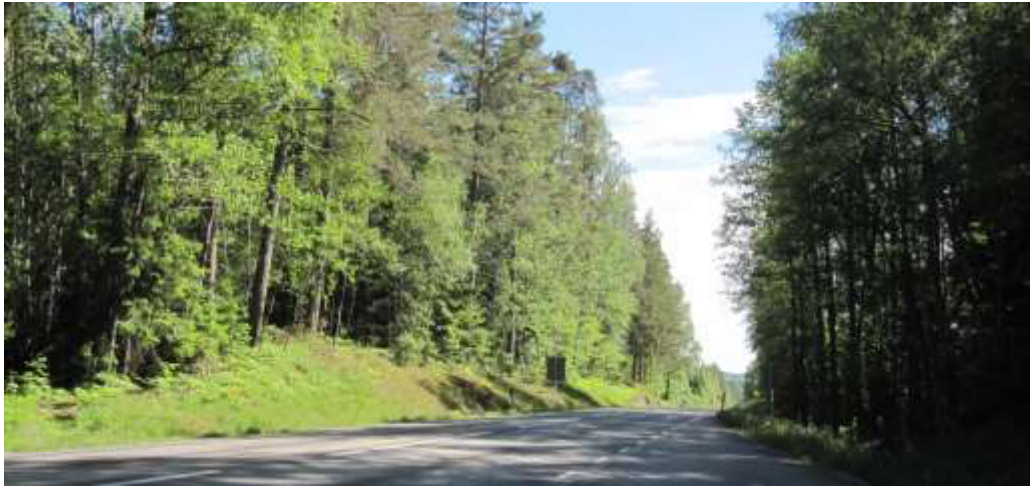
Bild 13. Väg 50, Brattebro backe.
