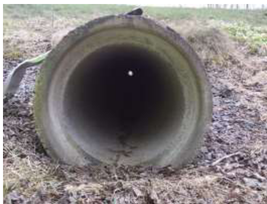
Bild 15. Torr betongtrumma med diameter 500 mm, befintlig väg 50. Trumma som går torrt och eventuellt kan användas av mindre däggdjur trots sin ringa diameter.
