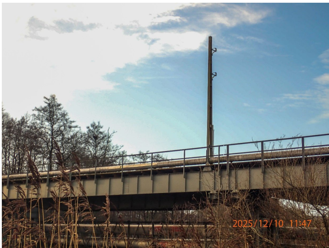
Figur 8. Befintlig bro över Sävån, vy från öster. I bildens nederkant syns befintlig fjärrvärmeledning på en fackverkskonstruktion under bron.
