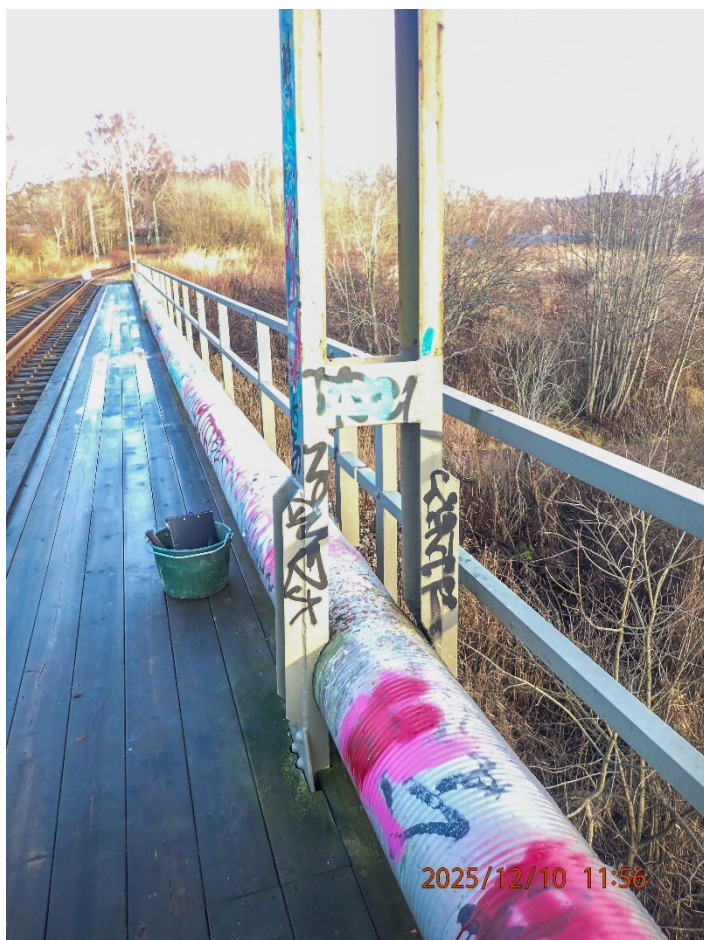
Figur 9. Befintlig kontaktledningsstolpe på bron, utskuren för att ge plats åt gasledningen.
