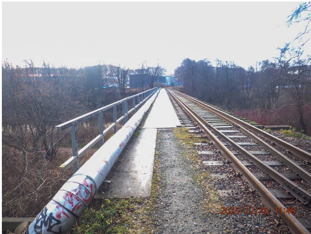
Figur 10. Bron över Säreån, med gasledningen till vänster på bron. Vy från norr.
