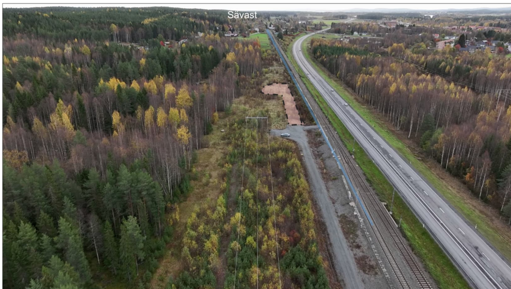
Figur 25. Schematisk redovisning av nytt spår i blått, öster om befintligt spår, samt ny serviceväg som förlängning av befintlig serviceväg.
