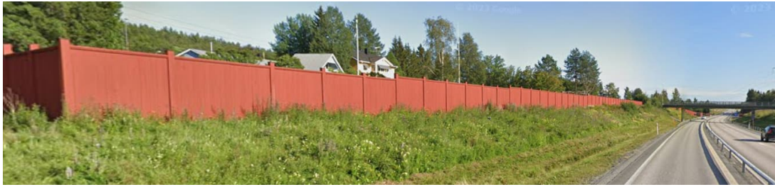
Figur 3. Bild på bullerskyddsskärm i trä målad med röd slamfärg längs Lulevägen (väg 97). Bild från google maps.
