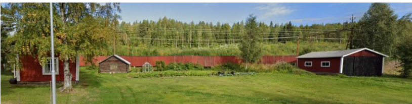
Figur 7. Foto av befintliga bullerskyddsskärmar i Sävast.
