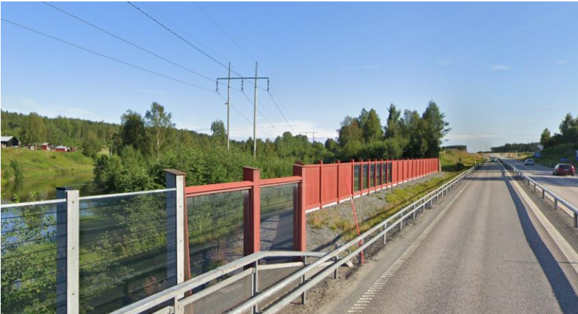
Figur 18. Bild på bullerskyddsskärmar med inslag av transparenta paneler längs med Lulevägen (väg 97).
