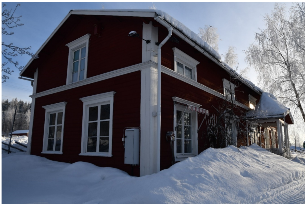
Foto 5 Fasad mot väst.
