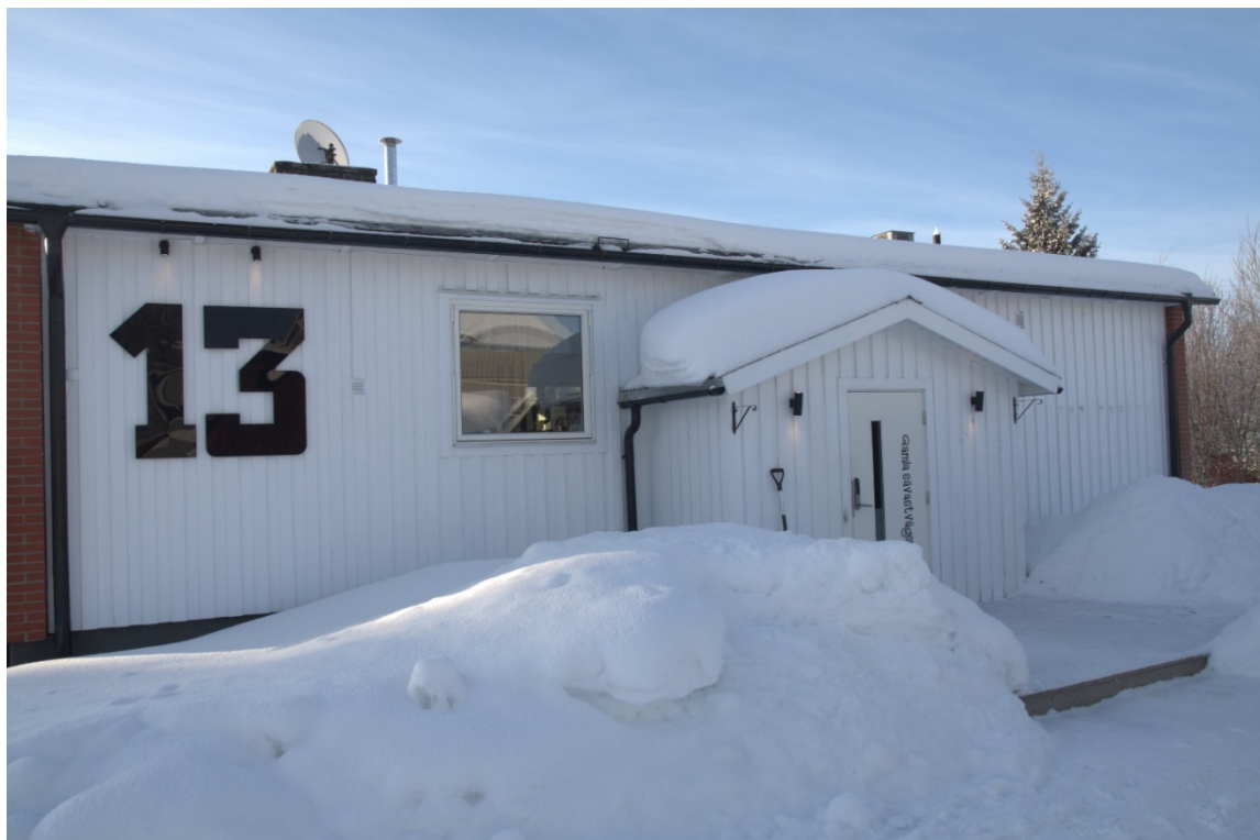
Foto 13 Fasad mot öst.
