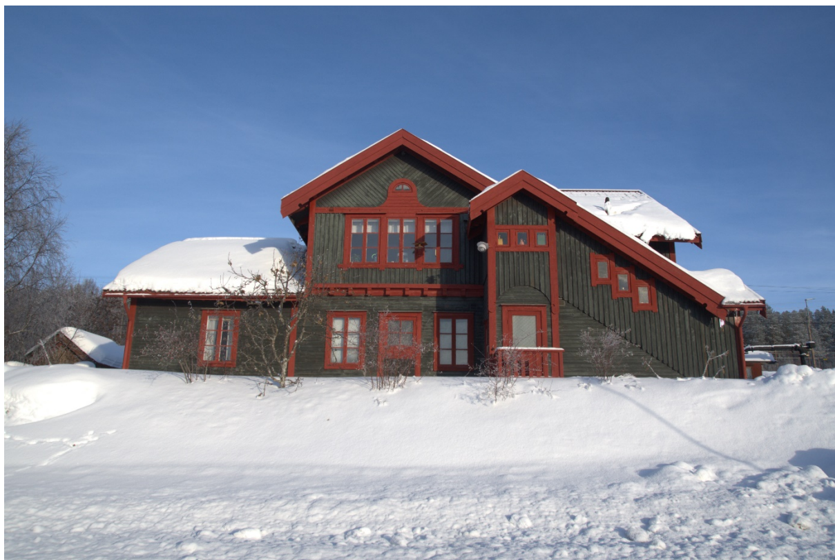
Foto 15 Fasad mot väst.
