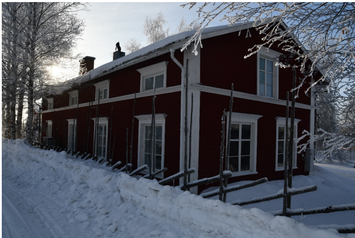
Foto 6 Fasad mot öst.
