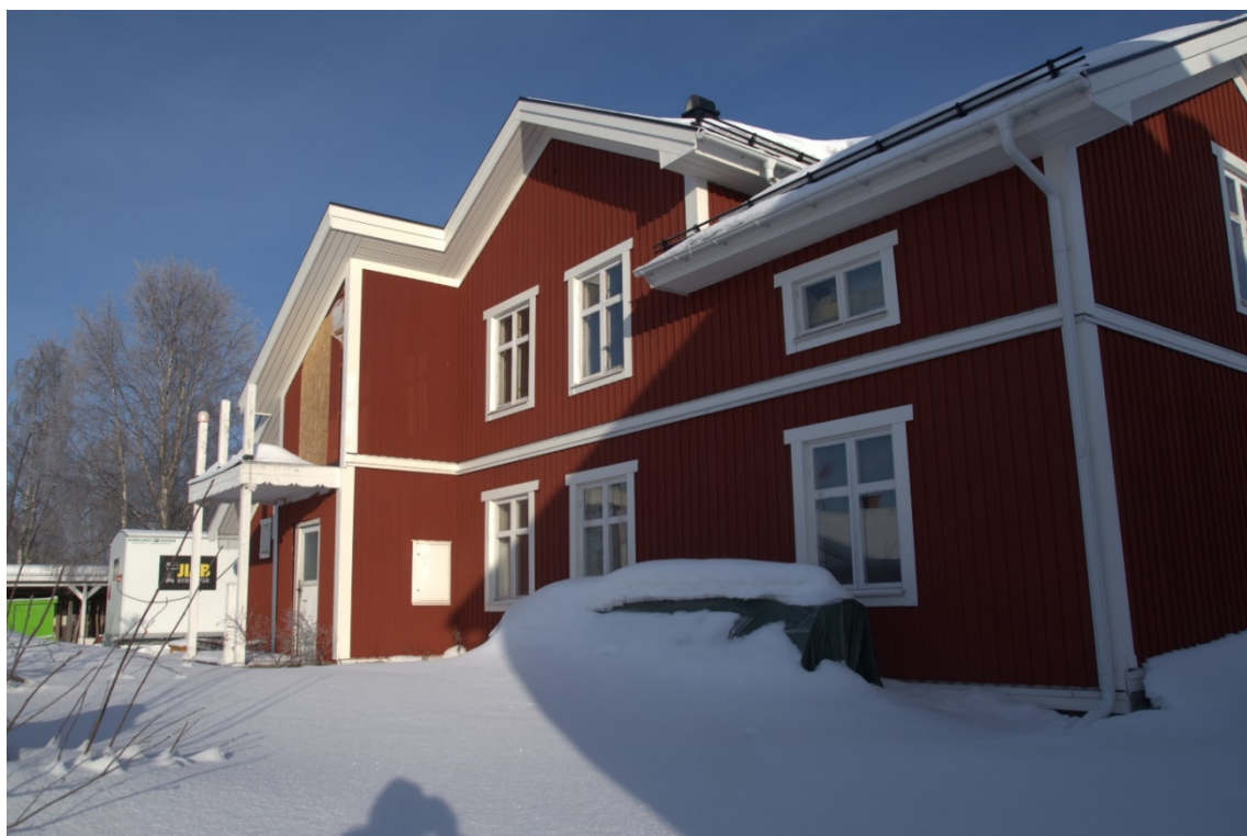
Foto 8 Fasad mot väst.
