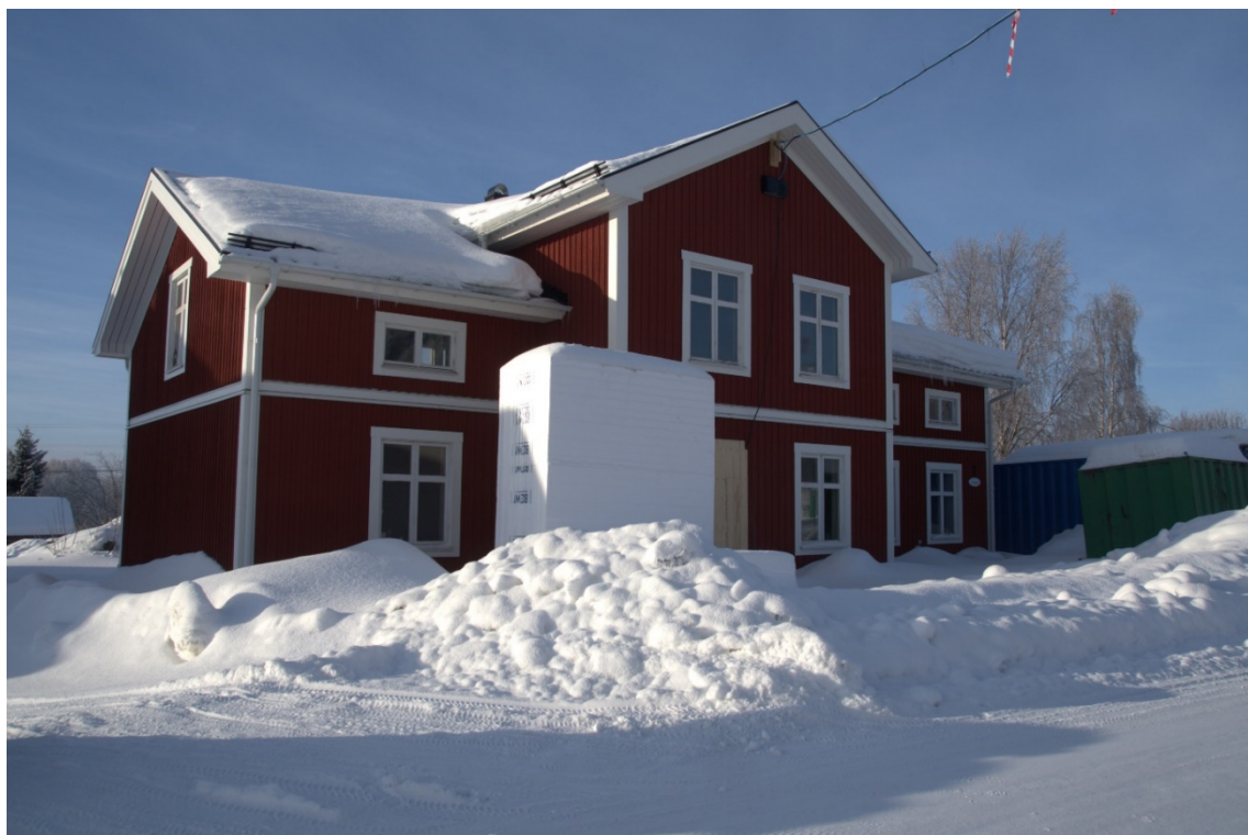
Foto 7 Fasad mot öst.
