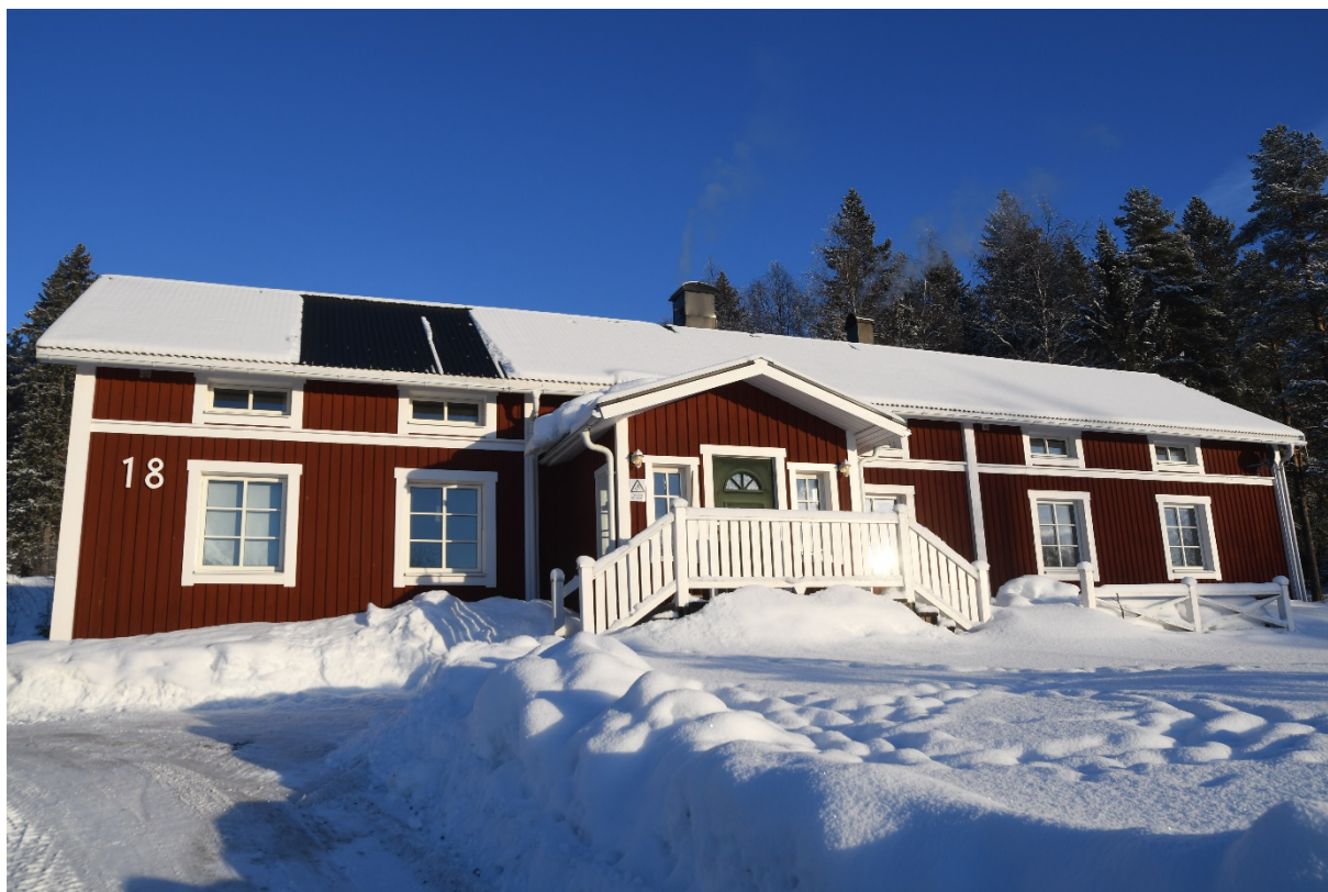
Foto 25 Fasad mot väst.
