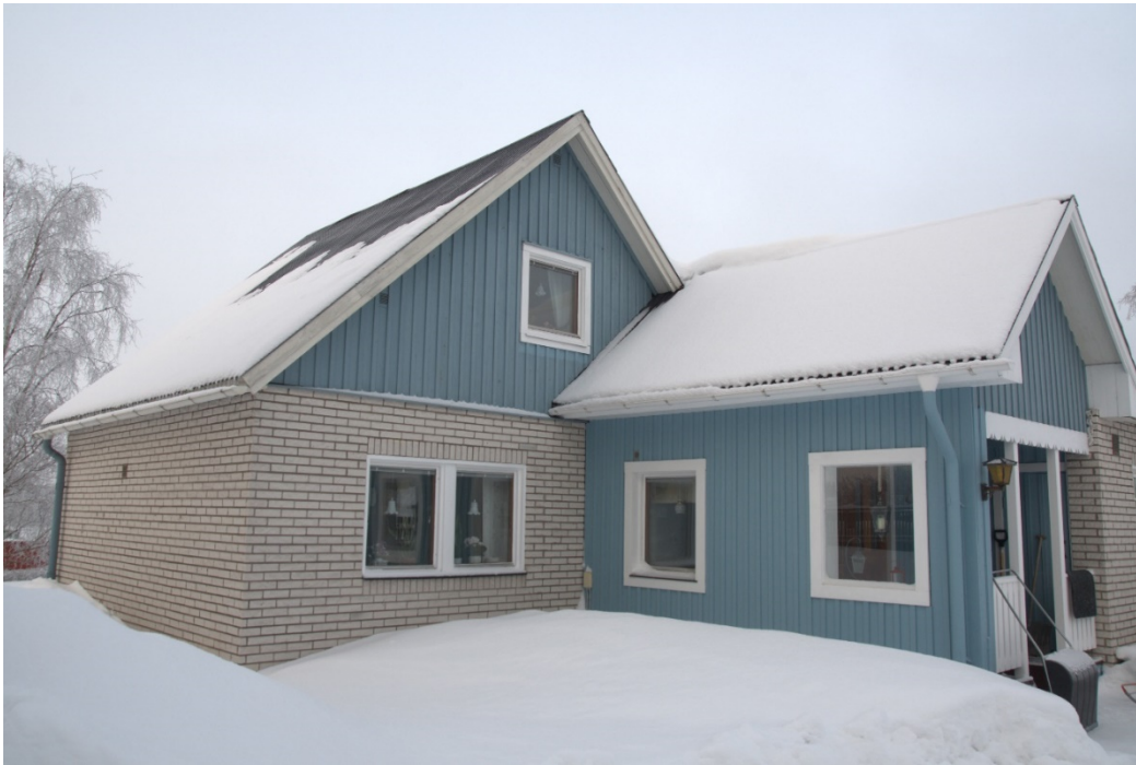
Foto 1 Fasad mot öst.
