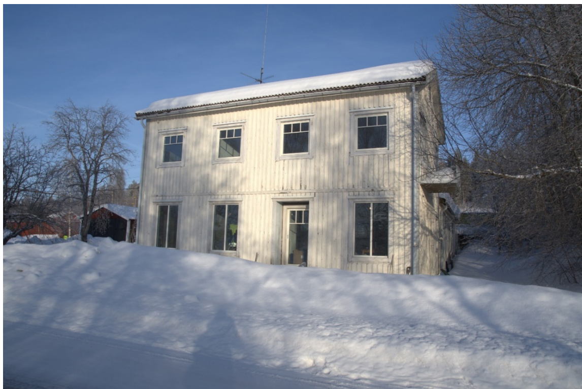
Foto 11 Fasad mot väst.
