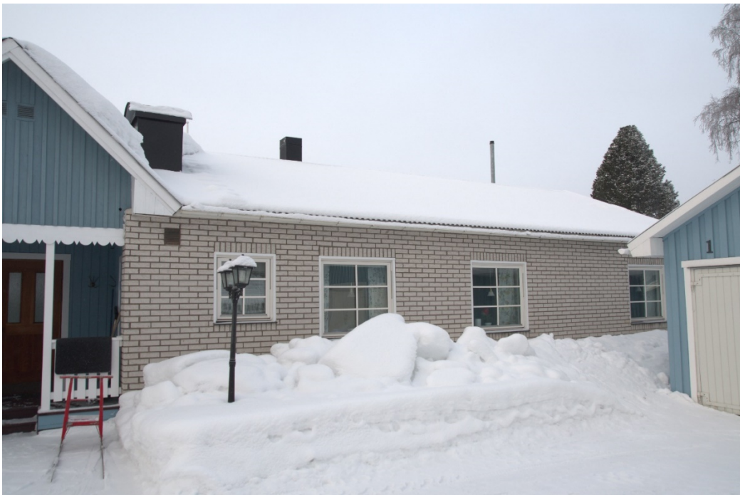
Foto 2 Fasad mot öst.
