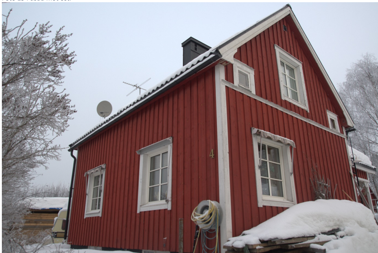
Foto 20 Fasad mot väst.
