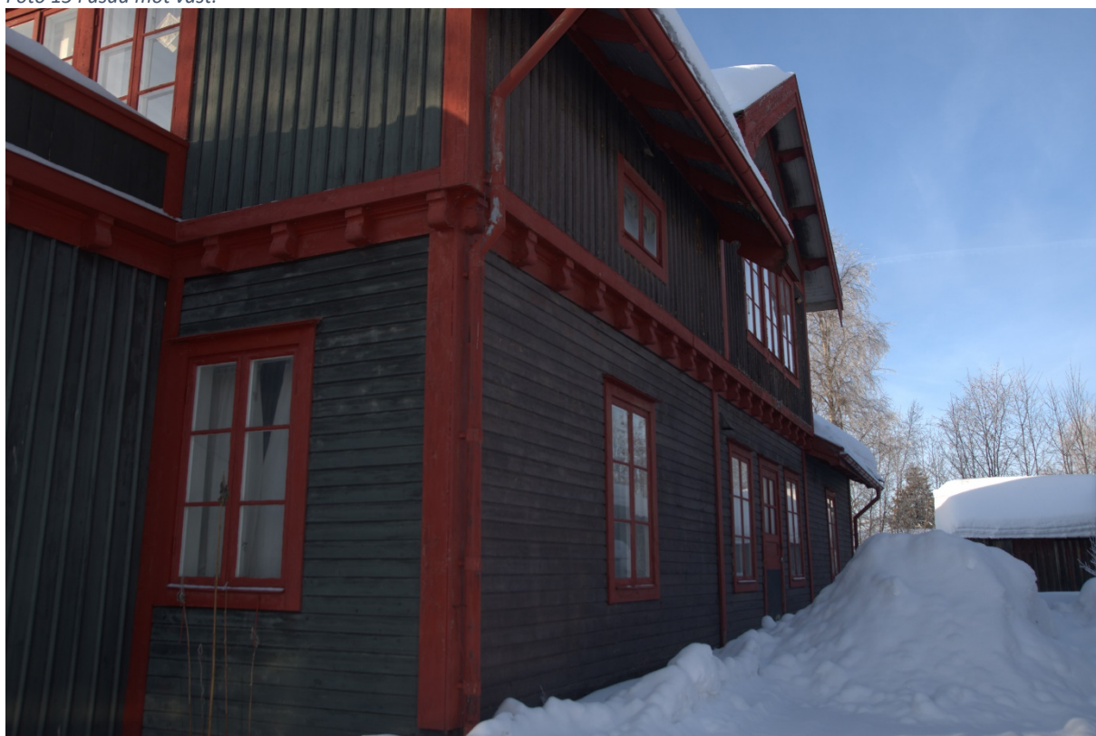
Foto 16 Fasad mot öst.
