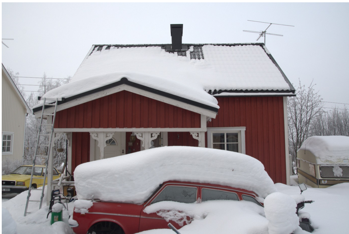
Foto 19 Fasad mot öst.
