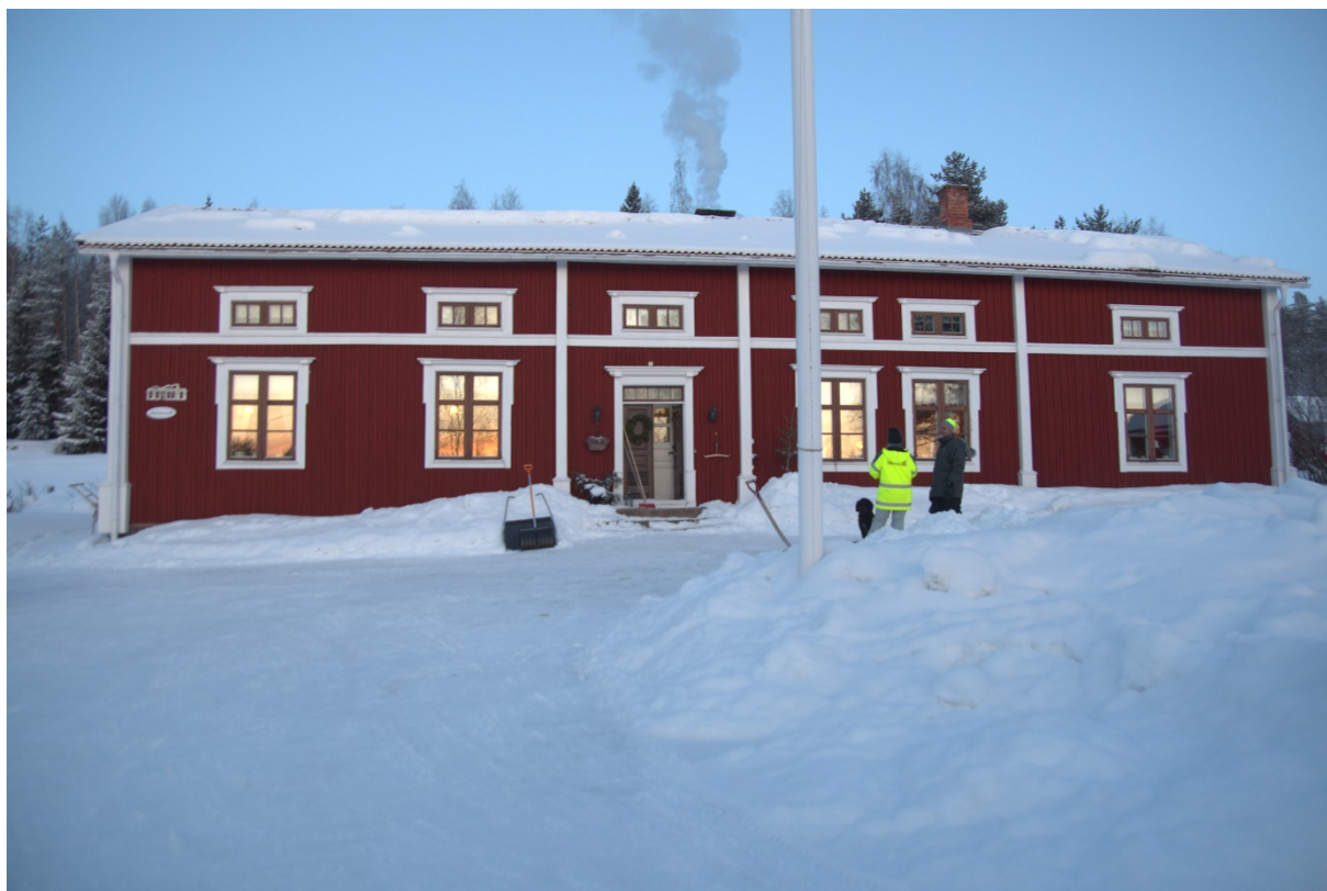
Foto 23 Fasad mot väst.
