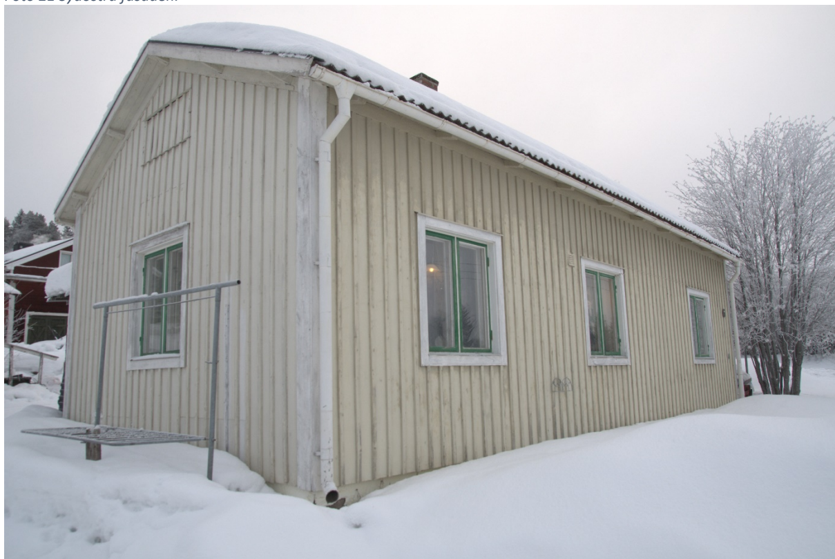
Foto 22 Fasad mot väst.
