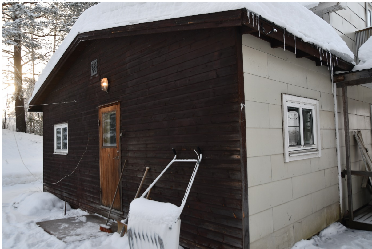
Foto 32 Fasad mot öst.
