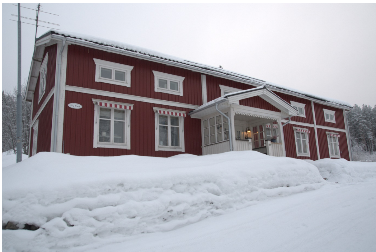
Foto 27 Fasad mot väst.
