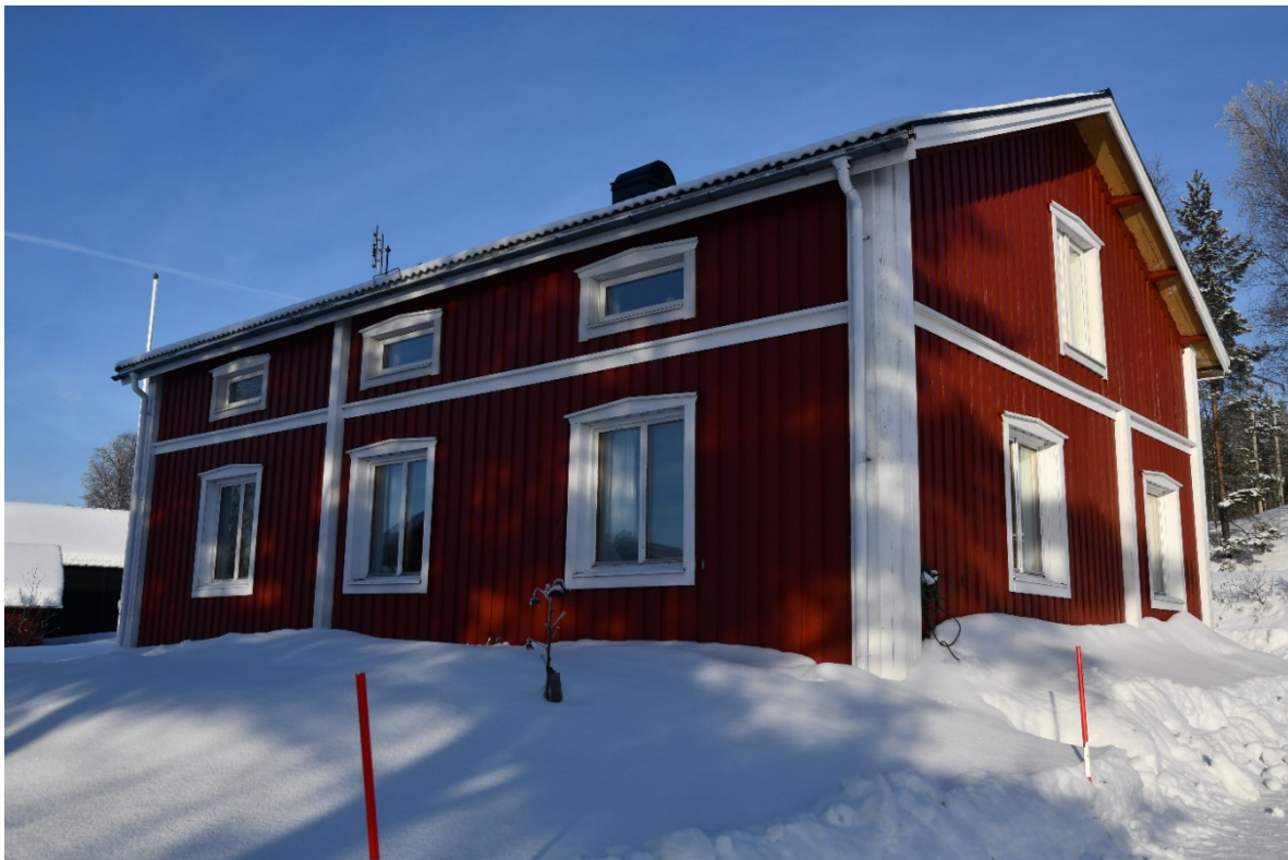
Foto 18 Fasad mot väst.
