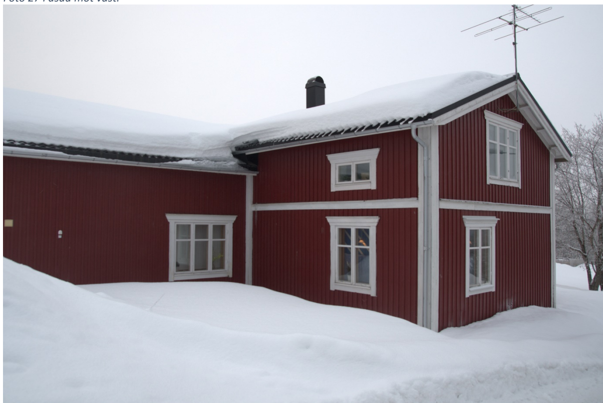
Foto 28 Fasad mot öst.
