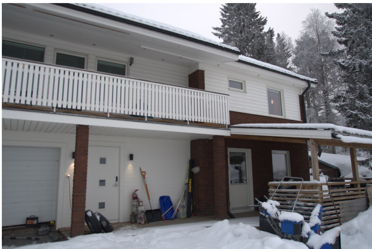
Foto 29 Fasad mot väst.
