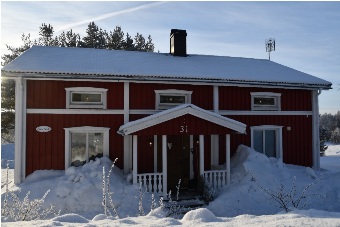
Foto 17 Fasad mot öst.
