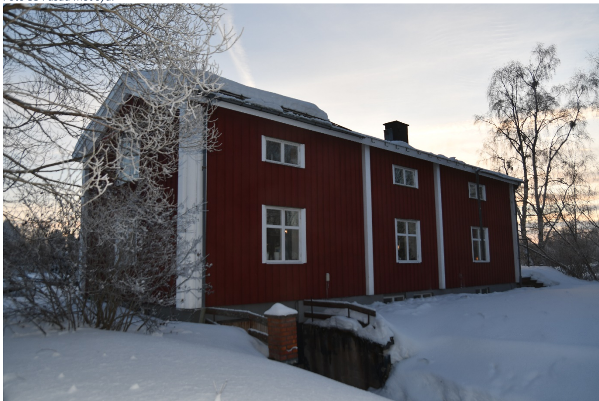
Foto 34 Fasad mot norr.
