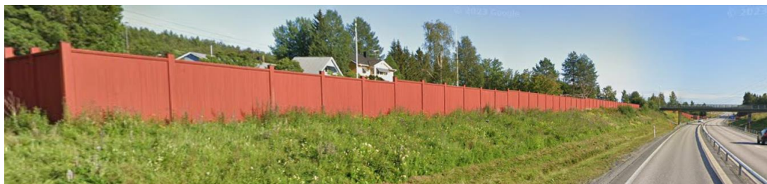
Figur 36. Bild på bullerskyddsskärm i trä målad med röd slamfärg längs Lulevägen (väg 97).
