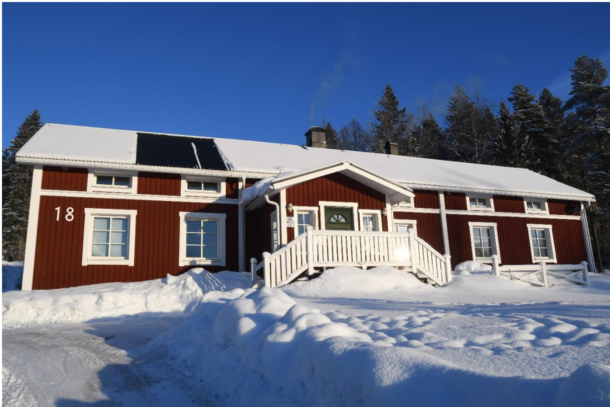
Foto 25 Fasad mot väst.
