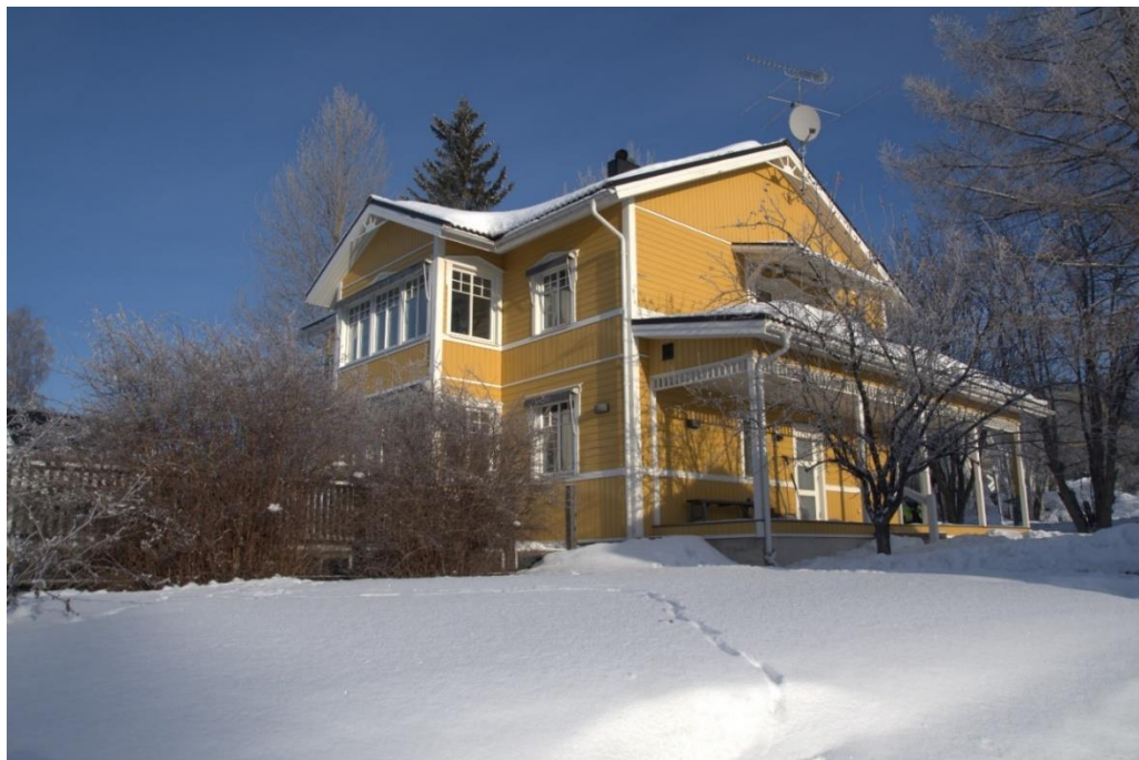
Foto 3 Fasad mot väst.
