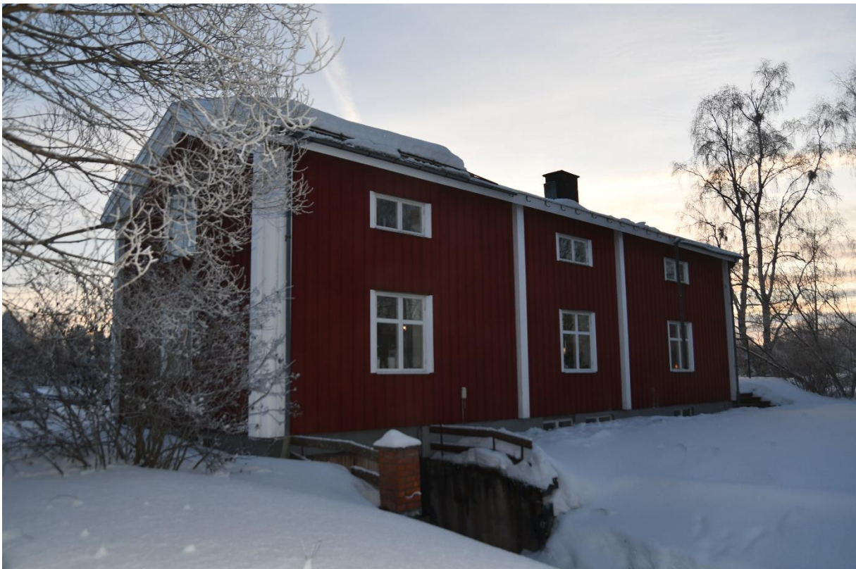
Foto 32 Fasad mot norr.
