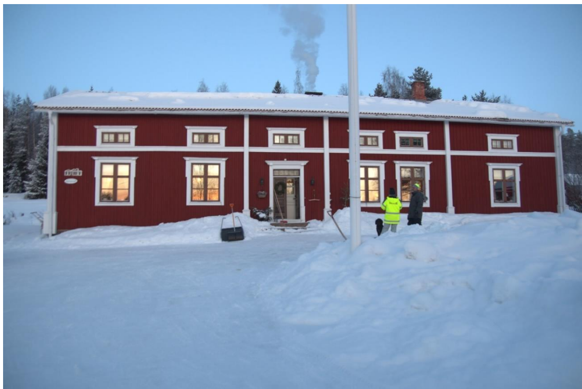
Foto 23 Fasad mot väst.
