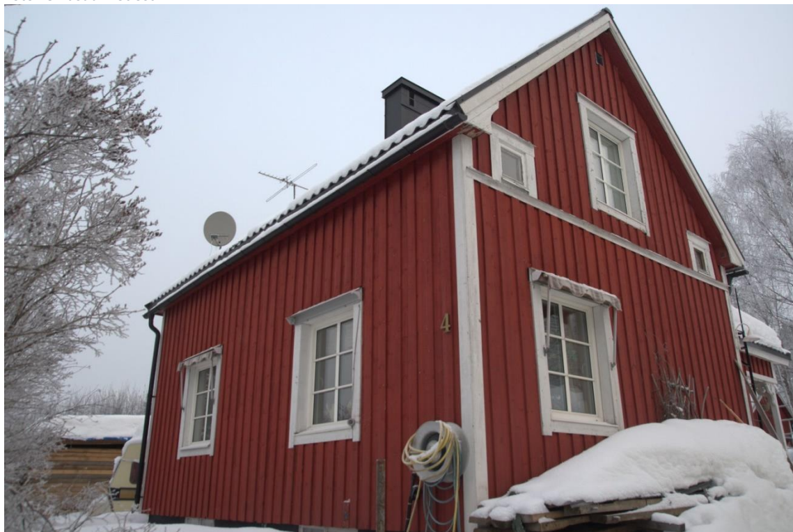
Foto 20 Fasad mot väst.
