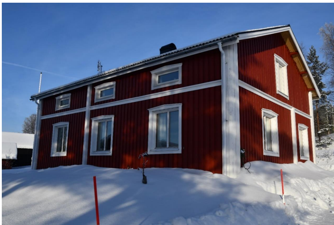
Foto 18 Fasad mot väst.
