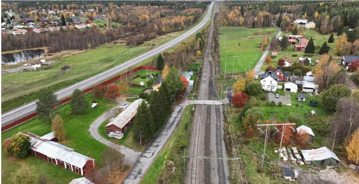
Figur 21 Fotografi över befintlig plankorsning sett från sydöst med Gamla Sävastvägen på vänster sida om järnvägen och Häradsvägen på höger sida om järnvägen.
