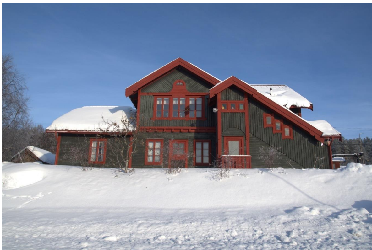
Foto 15 Fasad mot väst.
