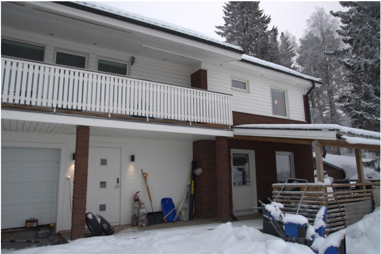
Foto 29 Fasad mot väst.
