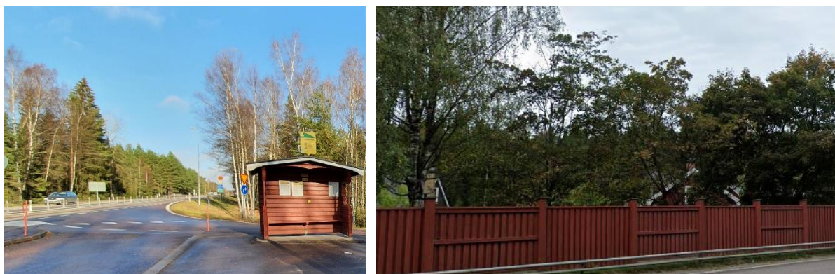
Figur 6.1. Befintlig busskur och bullerskyddsskärm som finns utmed väg 61/62. Ny skärm utförs med liknande utformning.
