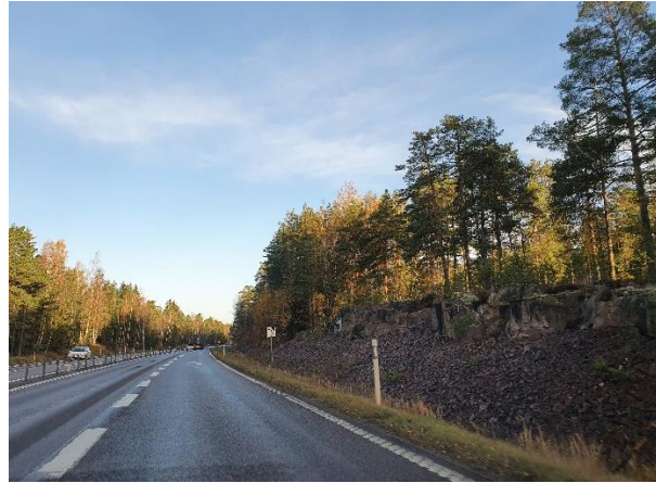
Figur 4.3. Foto som visar sprängstensslänter på södra delen av sträckan. Vy sett från söder mot norr.
