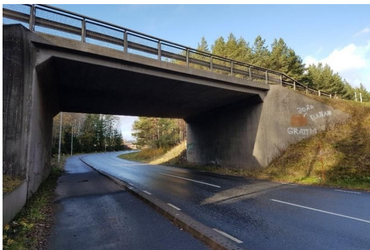
Figur 4.8. Bron över Körkarlsvägen och sandiga vägslänten till höger i bild.
