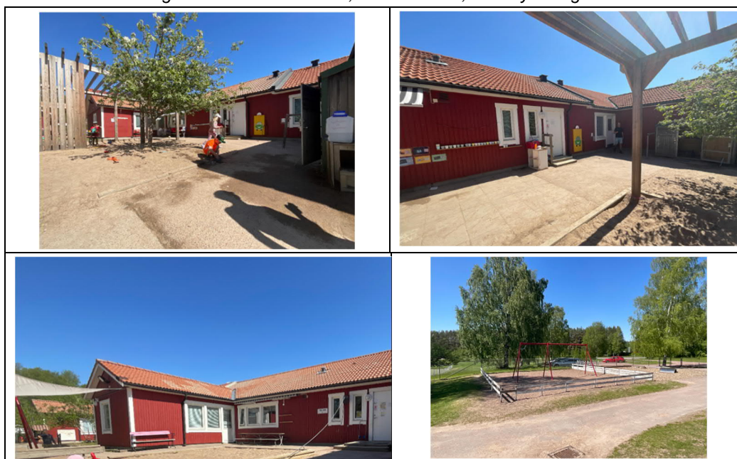
Figur 11. Bullerberörda förskolebyggnader vid Styvervägen, fasader och lekyta mot väg 61/62.
