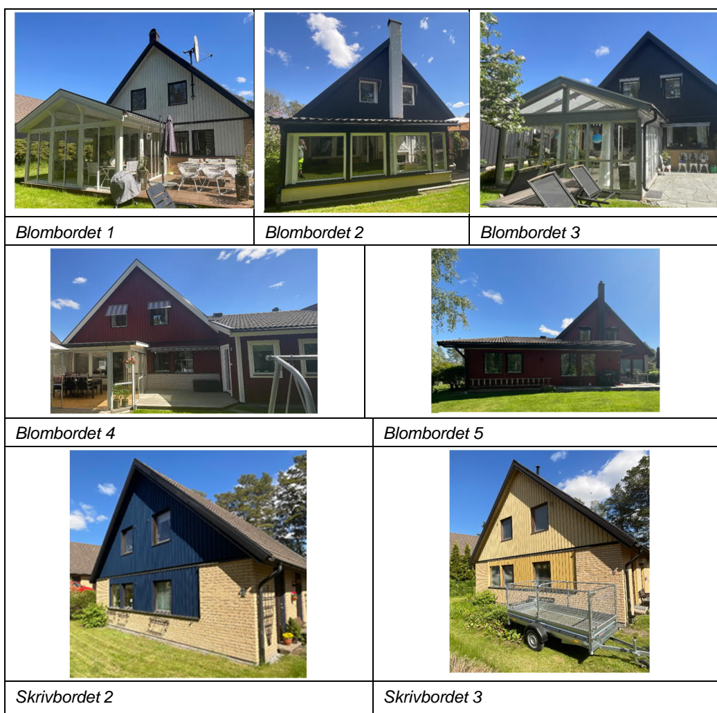
Figur 5. Bullerberörda bostadsbyggnader vid Lille Mats väg, fasader mot väg 61/62.
