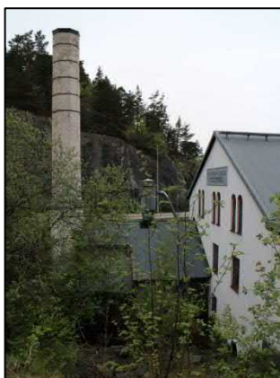
Bild 12. Den före detta kvarnbyggnaden från 1870-talet som idag rymmer snickeri, har ett tidstypiskt utförande av fasader och fönster (Nacka, 2011).
