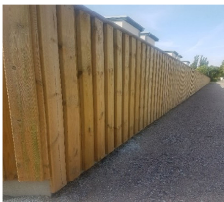
Figur 8. Foto som visar exempel på träskärm med träavtäckning, istället för röd plåt. Träskärm sätts på de delar där inte putsad mur föreslås.
