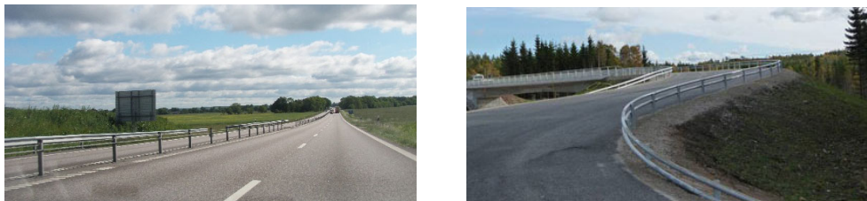
Figur 4. Exempelbilder på vajerräcke i mitten av vägen och rörräcke som sidoräcke.
