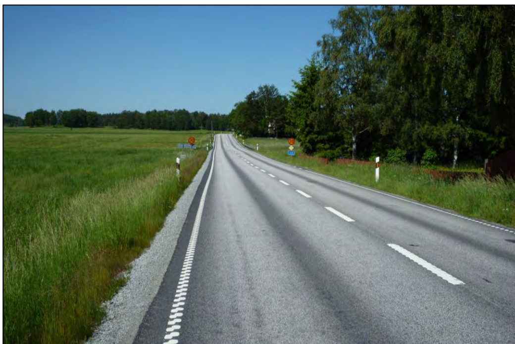
Figur 23. Separat infrastruktur för gående och cyklister saknas längs större delen av vägen.
