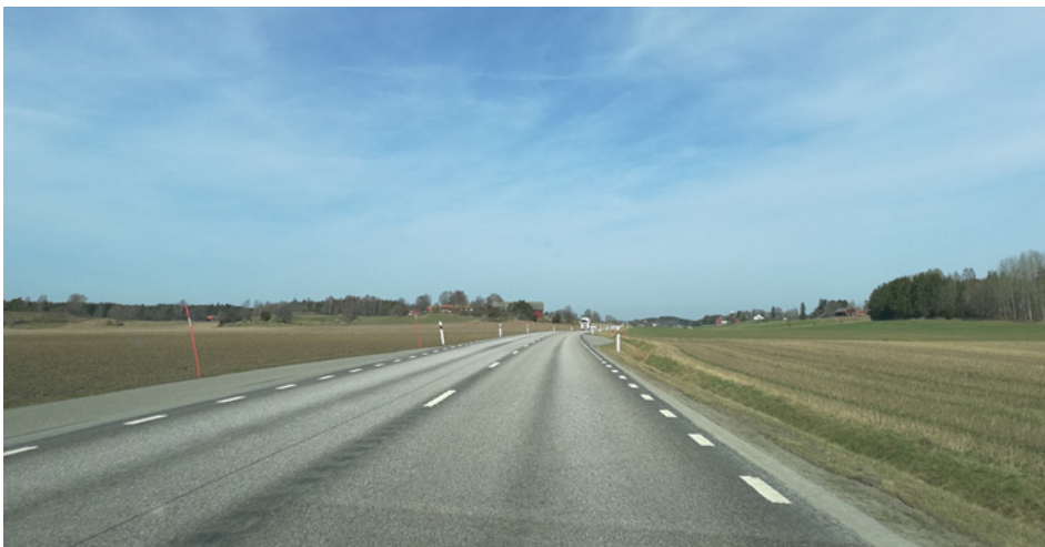
Bild 5. Befintlig väg 35 ur ett trafikantperspektiv. Utblickar ges över det öppna landskapet med några landmärken som ladan i fonden. Vägbanan ligger nära marken intill och mängden utrustning är liten.
