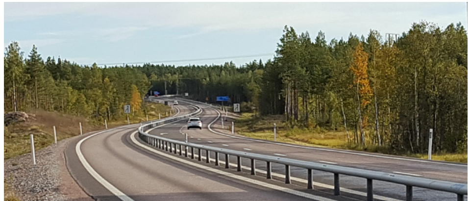
Bild 18. Fint exempel på hur mängden räcken minimerats, Utan sidoräcke minskar känslan av en vägkorridor och vägen blir en del av landskapet.
