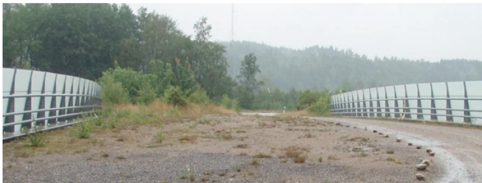
Bild 11. Exempel på en enkel viltpassage över en väg, en tänkbar lösning för viltpassagen vid Björntorp. Foto från Trafikverkets rapport 2011:159, effektiv utformning av ekodukter och faunabroar.
