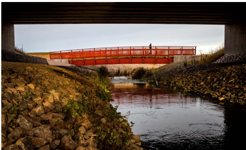
Figur 13. Moelvans limträbro över Skenaån i Skänninge (foto: Moelven Töreboda).
