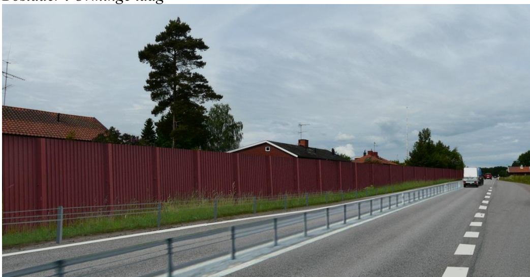
Bostäder i Örminge efter ombyggd väg och uppsatt bullerskyddsplank
