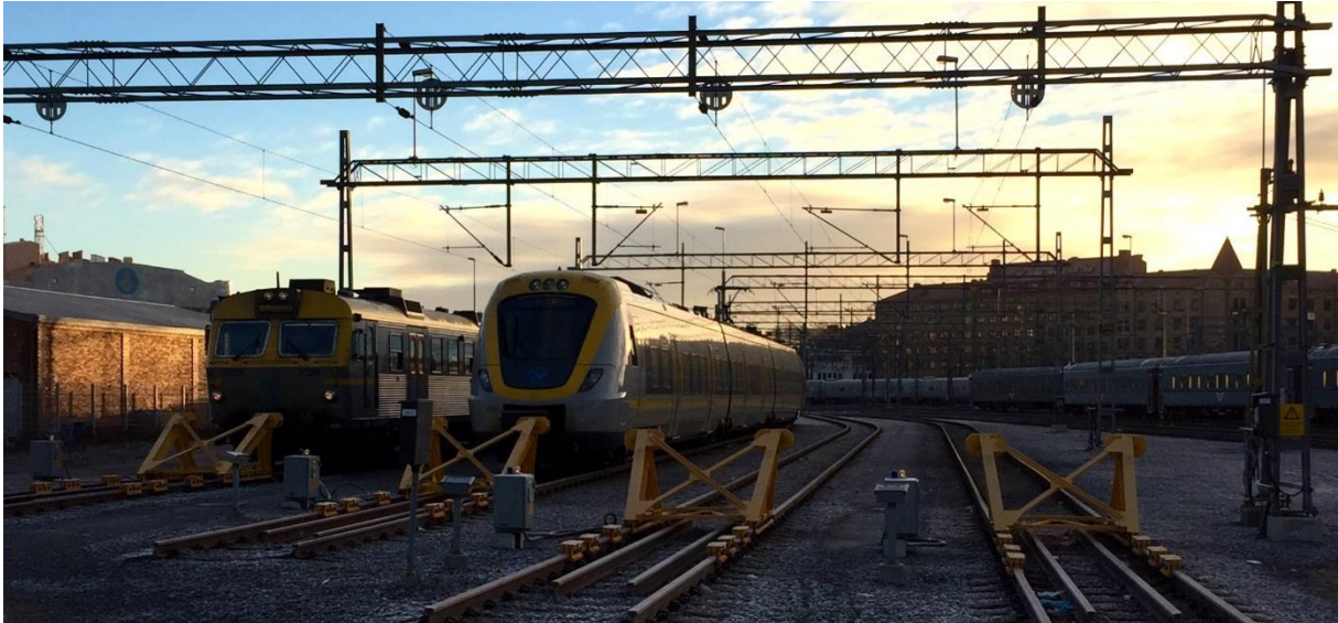
Figur 7 Uppställningsbangården vid Göteborg C.
