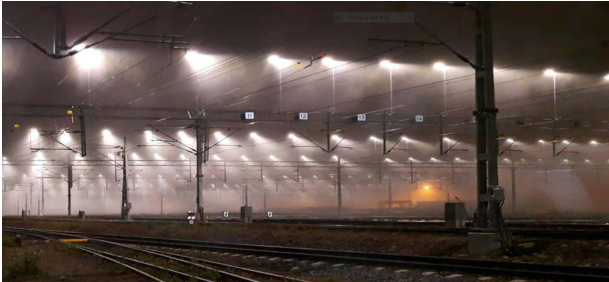
Figur 11. Föreslagen belysning med armaturer på kontaktledningsstolpar.
